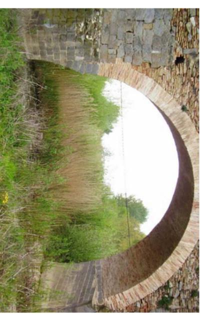
6. Bóveda de medio punto de ladrillo sobre arranques colapsados de sillares de piedra de Vilacolum
