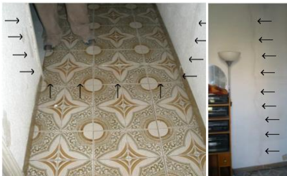
Figura 126: Continuitat de l'esquerda de mur per paviment (Castillejos, 168)
