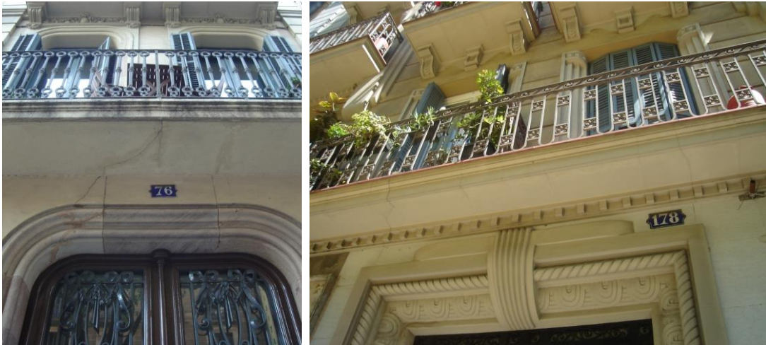
Figura 120: Exemples de llindes trencades en els accessos principals.
