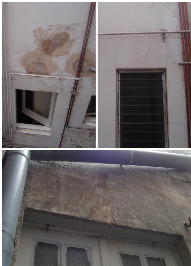
Figura 125: Llindes inexistentes trencades. Vilamarí, 27 (a dalt), Paral·lel 124 (a baix)
