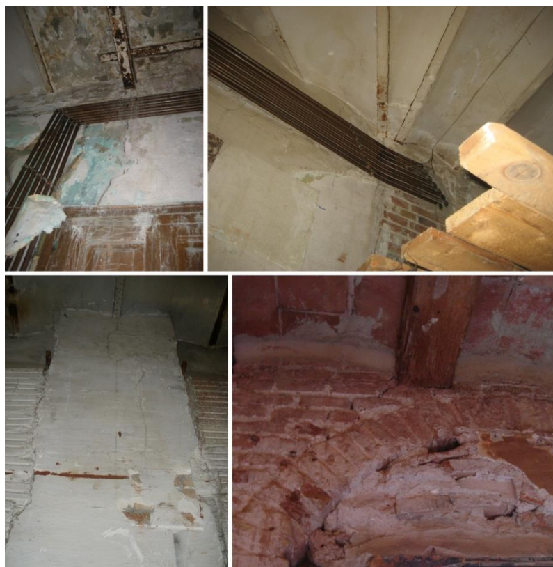
Figura 118: Exemples d'esquerdes sota recolzament de biguetes (1, 2 i 3 Castillejos 168, 4 Pau Claris, 76)
