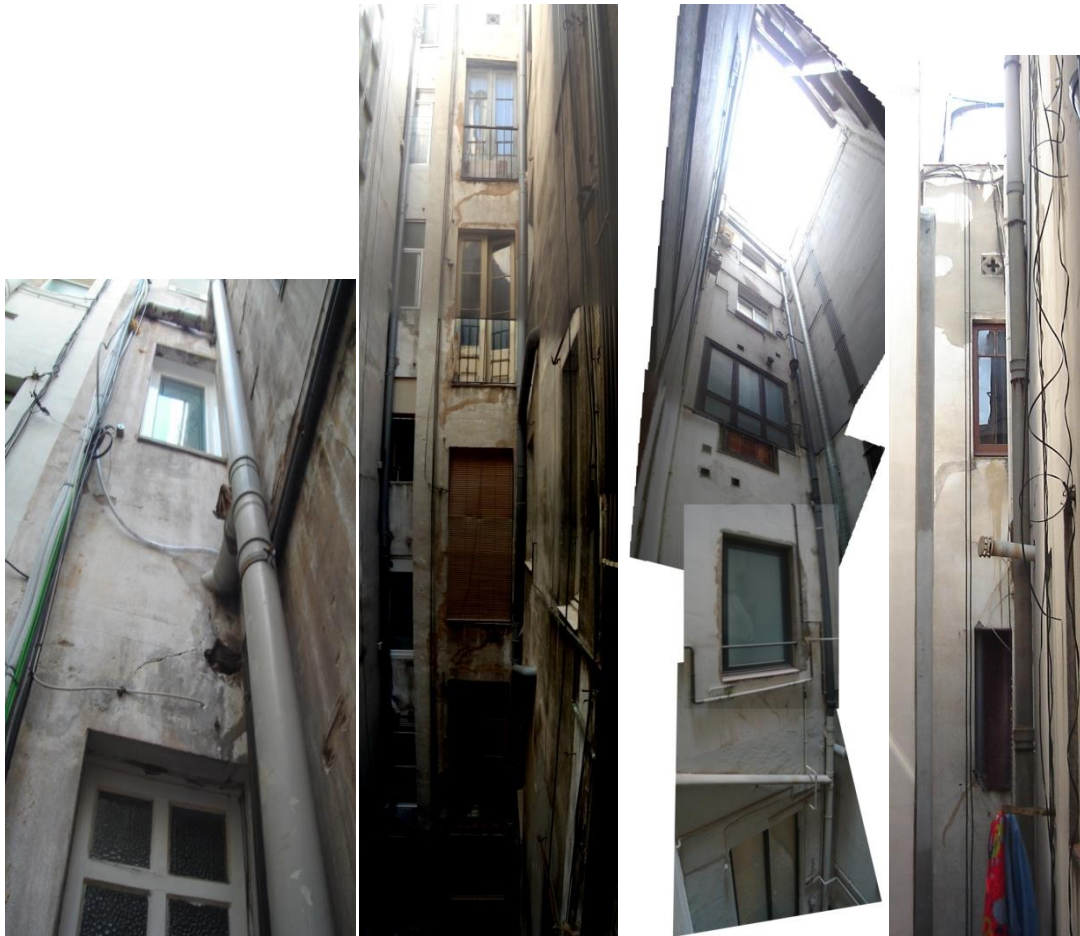
Figura 135: Esquerdes inclinades en patis mitgers, d'esquerra a dreta: Casanova 178, Paral·lel 124, Pau Claris 76, Provença 363
