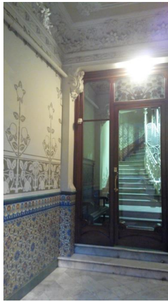
Figura 60: Pilastra de mur de vestíbul que recolza jàssera metàl·lica superior
