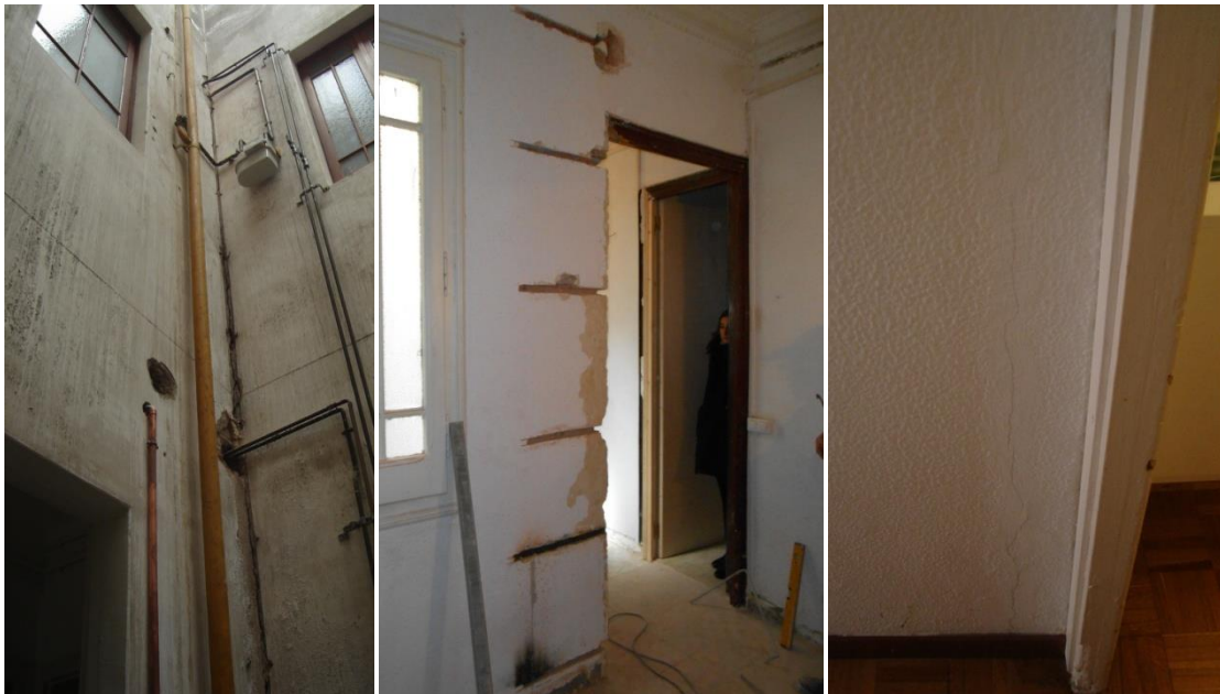
Figura 264: Esquerda entre murs de pati i el seu grapatge (esquerra) i continuació d'aquesta esquerra en mur oposat del pati en la cara interior (dreta)
