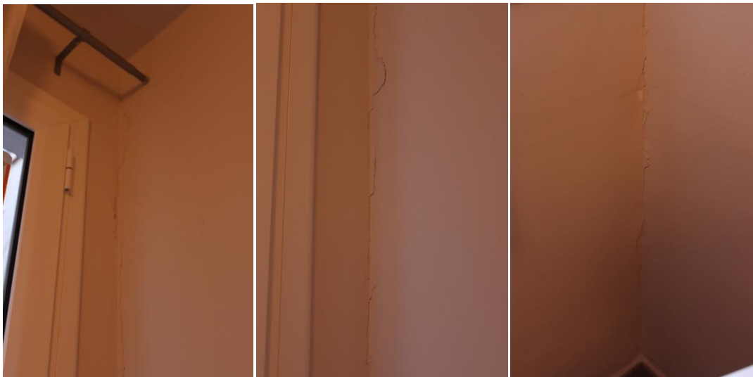
Figura 271: Esquerda entre envà i mur de pati central
