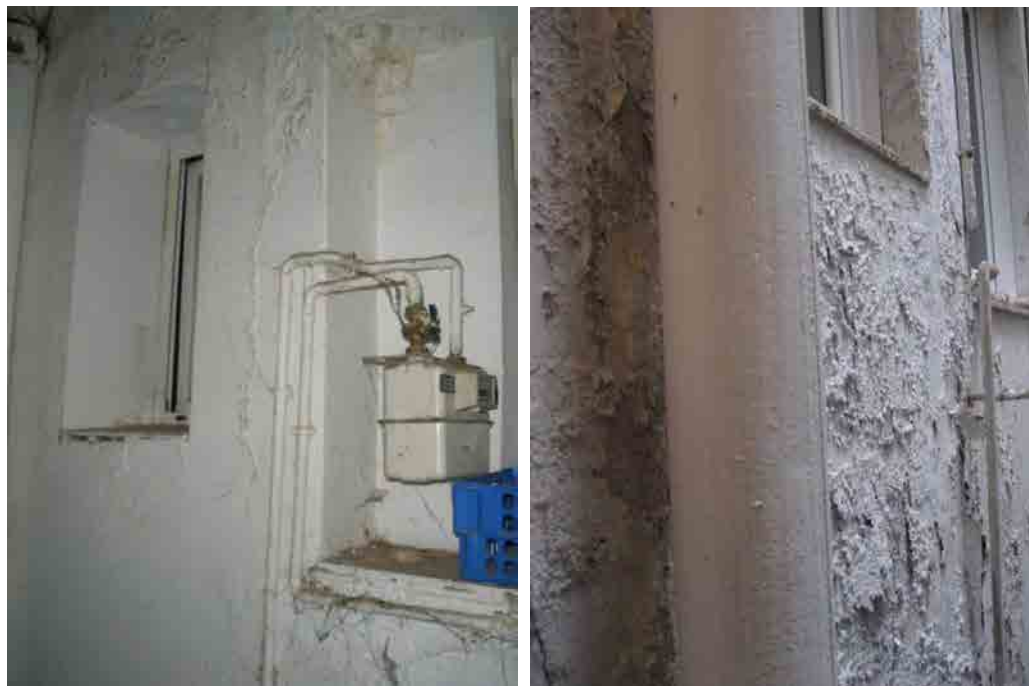
Figura 245: Humitats en mur de pati central a planta baixa
