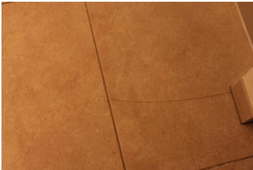
Figura 272: Esquerda en paviment en zona central de la planta
