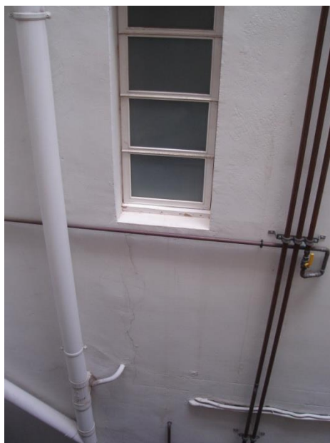
Figura 238: Esquerda vertical en mur mitger de la finca veïna
