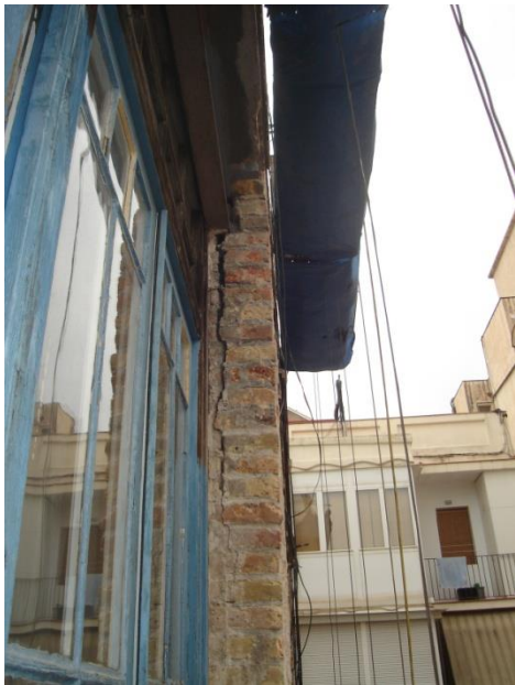
Figura 265: Esquerda en façana posterior en recolzament de bigueta metàl·lica
