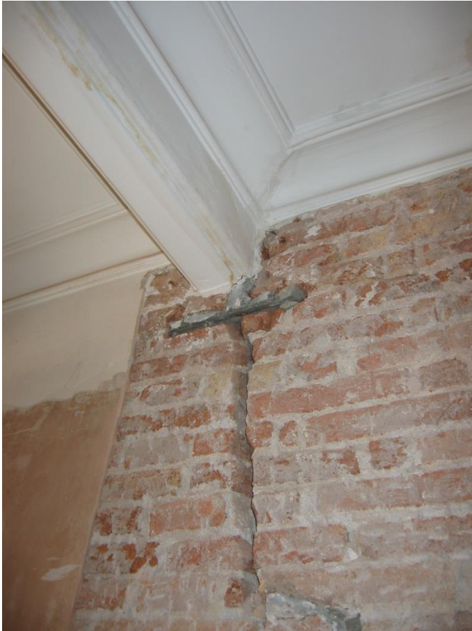
Figura 260: Grapatge d'esquerda en mitgera
