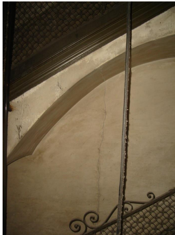
Figura 251: Esquerda en mur de caixa d'escala que es prolonga trencant la volta
