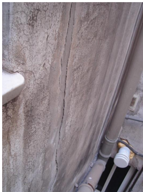
Figura 237: Esquerda vertical en mur mitger
