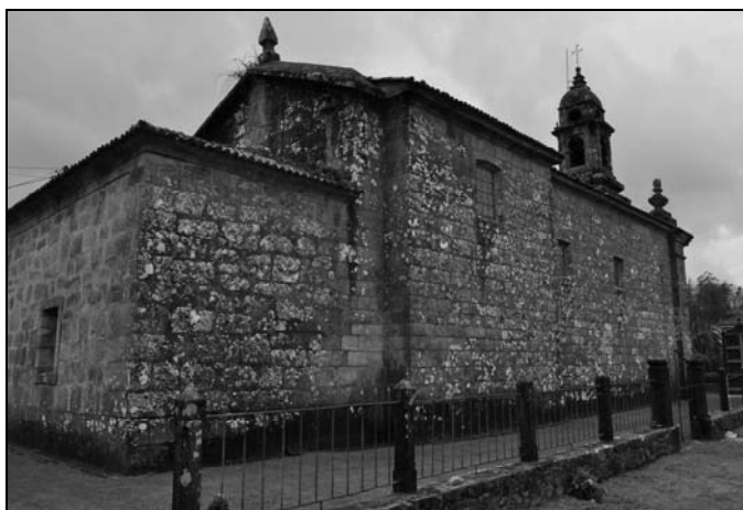
Fig. 50- Detalle de la iglesia de Broño, nótese la presencia de sillares reaprovechados en el muro norte de la sacristía
