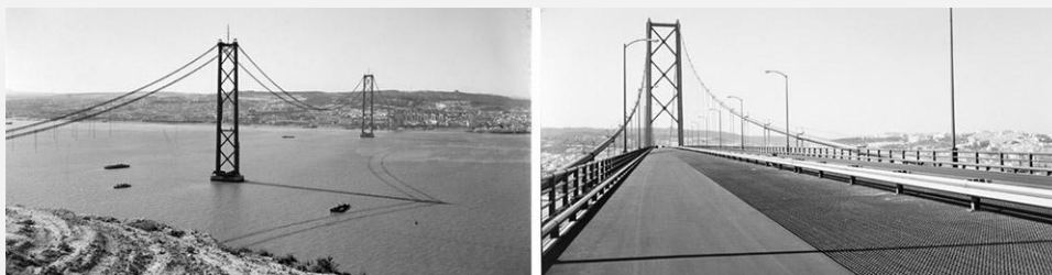
Fig. 38 | Ponte sobre o Tejo, vistas da construção. Fonte: BA FCG (Site)
