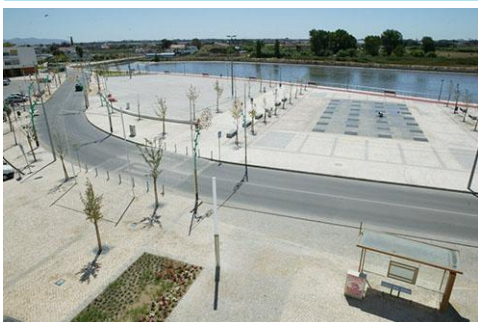
Fig. 160 | Envoltura à Caldeira da Moita. Fonte: CM Moita (site)
