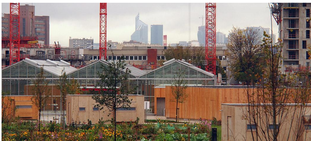
Fig. 55 | Construção do projecto “Docks de Saint-Ouen” nos arredores de Paris. Fonte Própria, 2013
