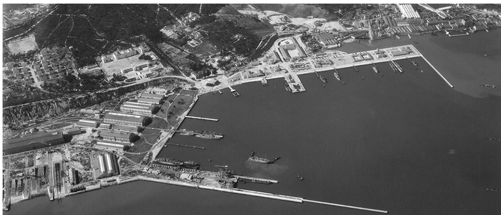
Fig. 37 | Vista aérea do Arsenal do Alfeite, Almada década de 1930. Fonte: BA FCG (Site)
