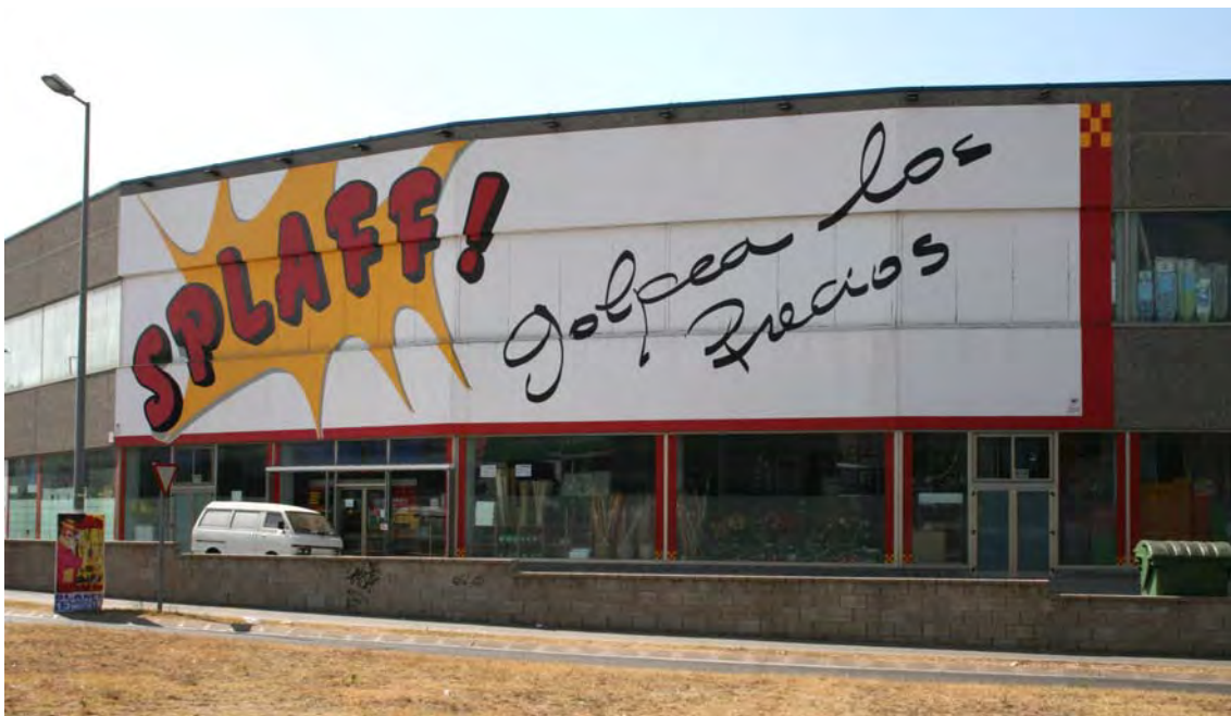
Figura 8.78. Sector PP Sector industrial ctra. de l'estació (Blanes). Edifici-rètol estrident amb productes "low cost" segons la fórmula tot a 1 euro. Font: Juli Valdunciel.
