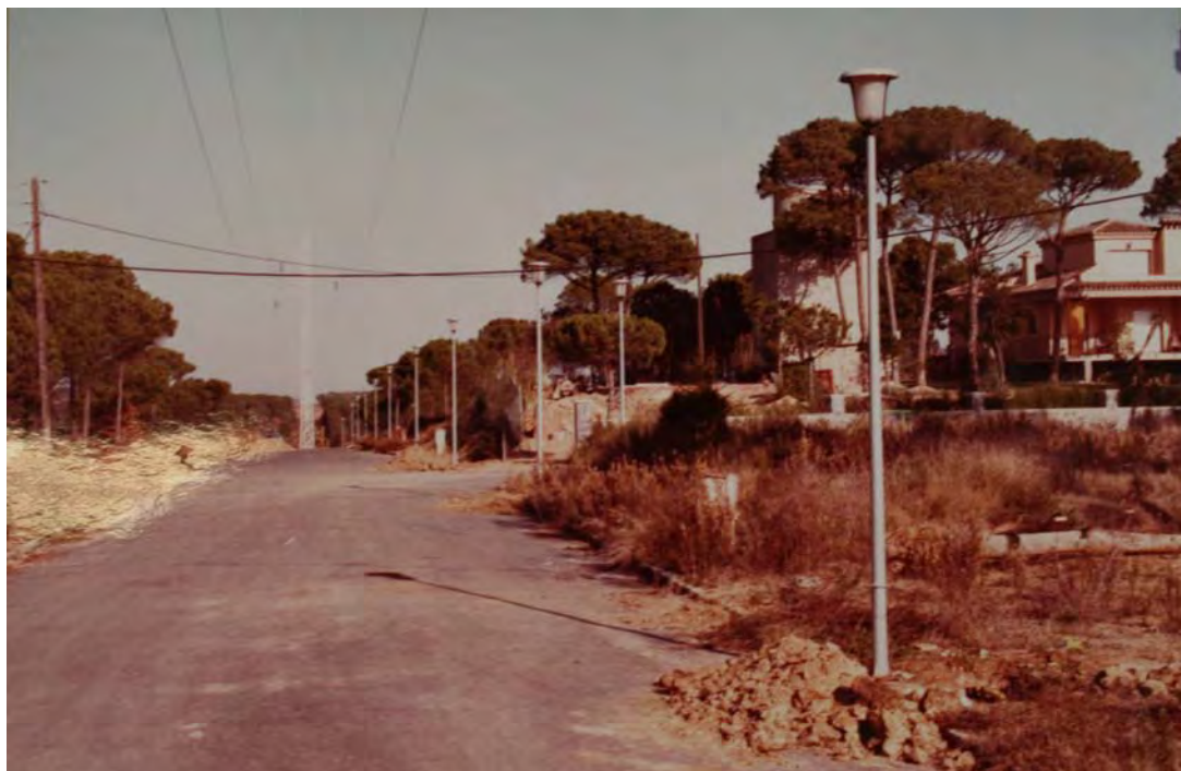
Figura 8.36. Urbanització Can Jordi (Aiguaviva). La fotografia, probablement realitzada a mitjan la dècada de 1980, acompanya el pla parcial que regularitza el sector (1989). Observi's la presència de runa enmig del paviment, la distribució caòtica del cablejat elèctric i telefònic i la colonització per part de la vegetació espontània de les parcel·les no edificades. Font: Arxiu Històric de Girona.
