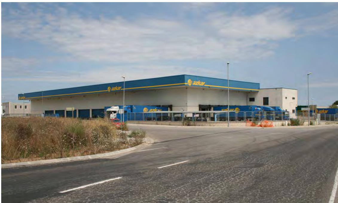
Figura 8.84. Empresa de transports ubicada al PP AU7-8 Industrial de Montfullà (Bescanó). Es tracta d'un edifici-contenedor, reconeixible pel logotip i el sistema de colors de l'empresa, amb una presència preponderant de molls de càrrega. Font: Juli Valdunciel.
