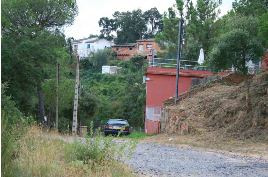
Figura 8.35. Zona hiperdegradada de la urbanització Riuclar (Massanes). Observi's el paviment, una fina capa de graves abocades damunt d'un camí de terra; l'edificació, uns mòduls autoconstruïts de rajola; i la manca de gestió de la vegetació, un element que pot afavorir la propagació d'incendis forestals. Font: Juli Valdunciel.
