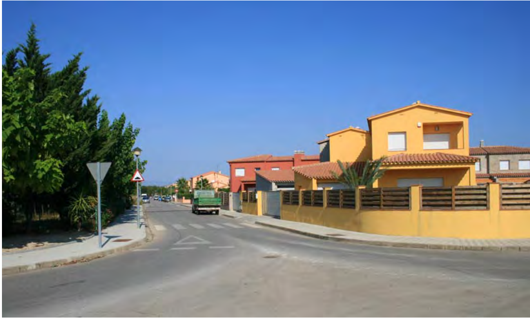
Figura 8.39. Urbanització La Torre (Avinyonet de Puigventós). Urbanització recepcionada situada a l'àrea urbana de Figueres amb uns nivells d'infraestructura i gestió acceptables. Font: Juli Valdunciel.
