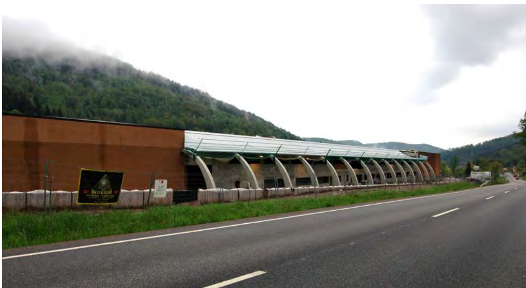
Figura 8.91. Nau del PP Industrial Can Birba (Camprodon). No es tracta de l'omnipresent edifici-contenedor, sinó d'una nau amb un tractament acurat quant a arquitectura i materials (acabat de maó i voltes centrals), dissenyada amb l'objectiu d'augmentar el valor de símbol de l'empresa. Malauradament, es tracta d'un pla parcial de nova planta ad hoc ubicat a redós de la carretera C-38. Font: Juli Valdunciel
