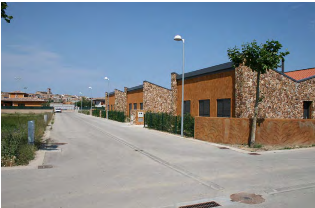
Figures 8.7. i 8.8. Planta i perspectiva del PP Sector sud (Albons). Eixample de molt baixa densitat del nucli d'Albons amb un perfil orientat també a la segona residència. Observi's l'edificació, concebuda segons un estil vernacular postmodern que, paradoxalment, no guarda cap relació amb les tipologies de tons terrosos clars d'aquesta zona del Baix Empordà. Font: Juli Valdunciel.
