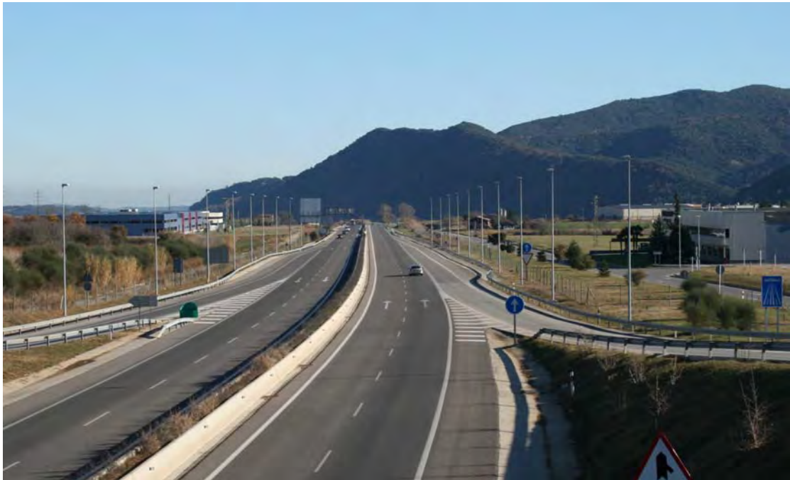
Figura 8.65. Perspectiva del PAE Pla de Politger (Sant Jaume de Llierca) des de l'autovia A-26. Es tracta d'una actuació (fora d'escala) impulsada, en una primera fase, per l'INCASOL amb l'objectiu de donar resposta a la demanda de l'àrea urbana d'Olot. Font: Juli Valdunciel.
