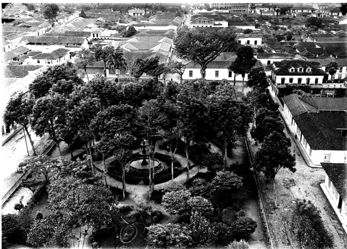
Fig. 14 Vista aérea del Parque de Bolívar, tomada en 1922, desde la Catedral de Villanueva. Se observa que, incluso en el marco del Parque donde se situaban las familias más prestantes del sector, casi todas las casas son de una planta. Con base en las pendientes de las cubiertas de teja de barro, puede apreciarse la disposición del patio interior, asimismo se aprecia un parcelario con pocas unidades por manzana, distintivo de los predios de los burgueses en el Medellín de la época. Autor: Fracisco Mejía. Fuente: Archivo Biblioteca Pública Piloto de Medellín.
