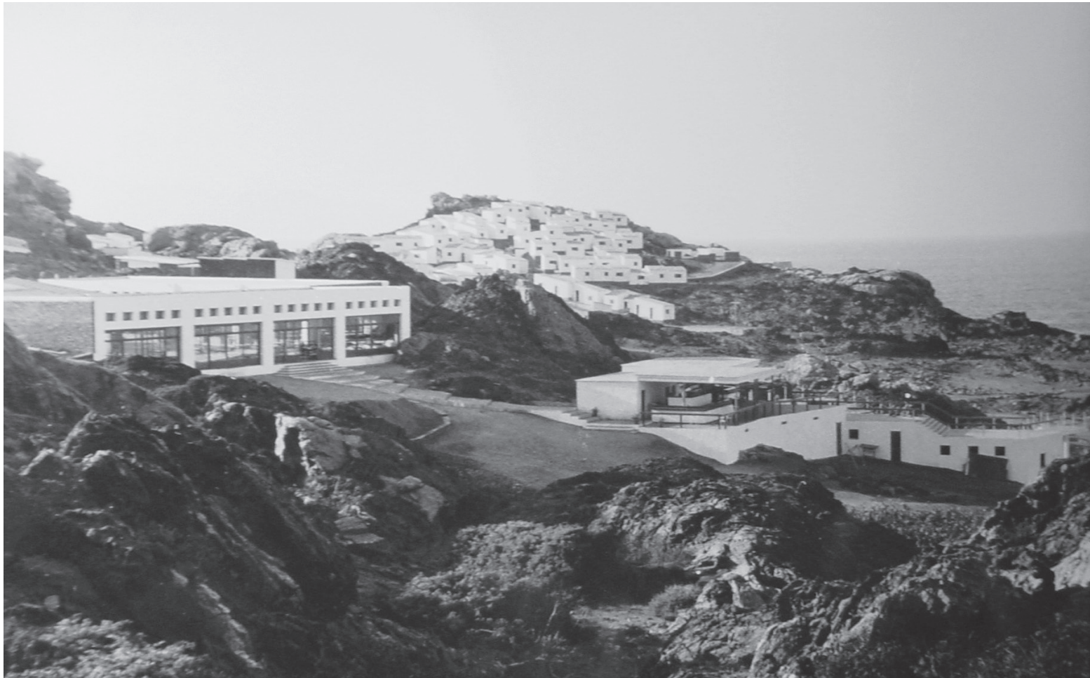
Projecte Club Mediterráneo, Cap de Creus Vista general edificacions del complexe 1962 Pelayo Martínez
