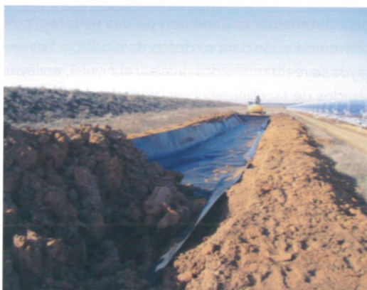
Figura 1: Acopio de suelo afectado en la planta.
