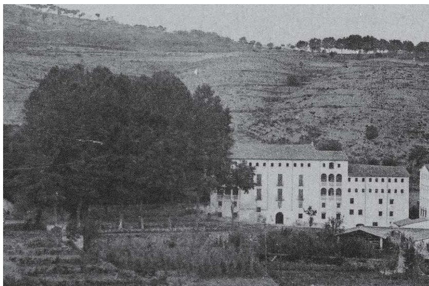
98. Façana principal de Ca l'Anton. La residència ocupa els dos pisos centrals de l'edifici major. A banda i banda s'observen les quatre galeries, les de l'esquerra parcialment ocultes pels arbres que delimiten l'accés a l'habitatge. (Fot. L. Roisin)
