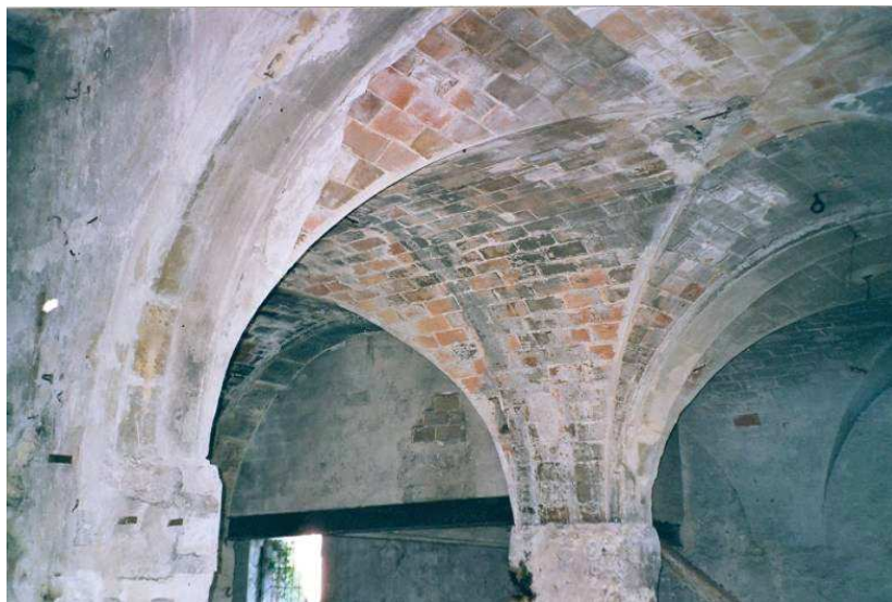
20. Molí Romualdet (Alcoi). Voltes per arista de la planta inferior (1999)
