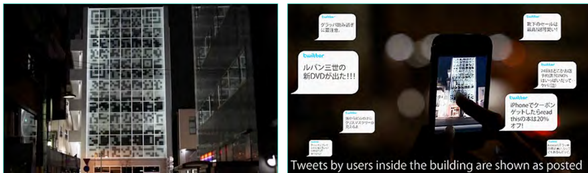
Fig. 102: N Building . Des de la façana s'estableix una relació textural interessant entre arquitectura i tecnologia.
