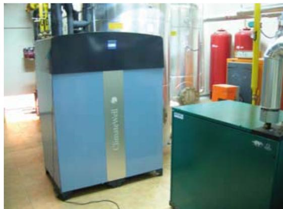
Figura 1.40. Configuraci3n de trigeneraci3n instalada por le proyecto Polysmart [56].
