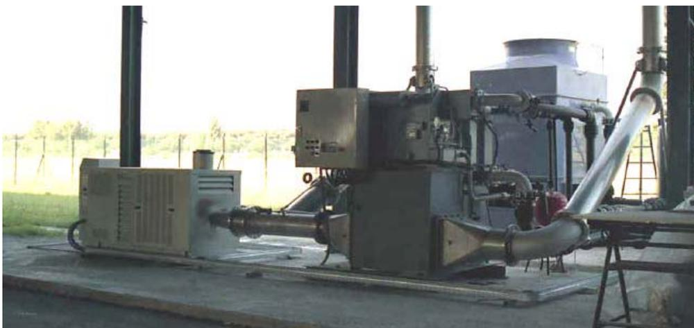
Figura. 1.47. Instalación de trigeneración en la Universidad de Pisa [73].
