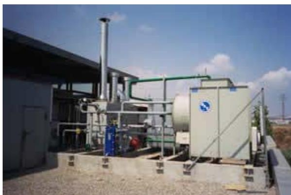
Figura 1.42. Vista general de la instalaci3n de trigeneraci3n del Hospitalet de Llobregat.
