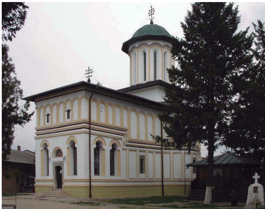
Vista sud-oest de l'església del monestir Plumbuita. Fotografia: LGM
