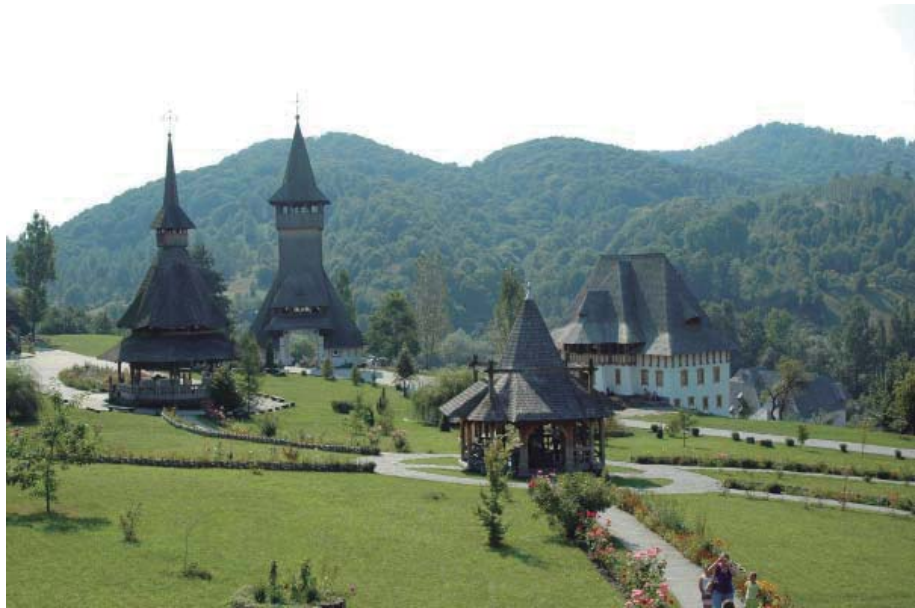
Conjunt del Monestir de Barsana (Maramures), en construcció des de 1994. (arq. Dorel Cordos). Fotografia: LGM
