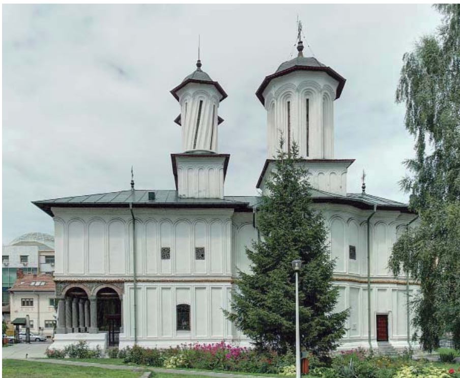
Vista frontal de la façana sud. Fotografia: LGM
