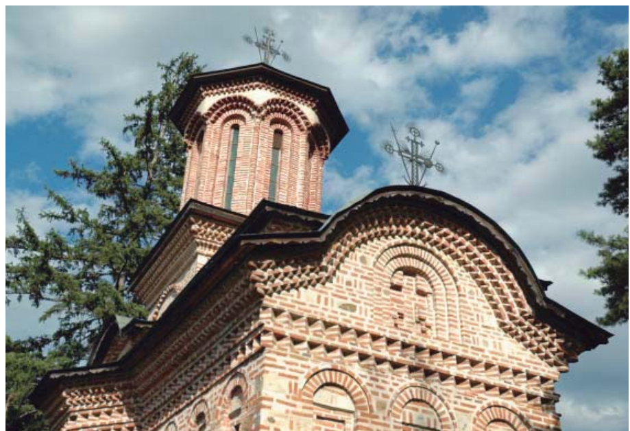
Detalls de la ornamentació de façanes i ràfecs. Fotografies: LGM
