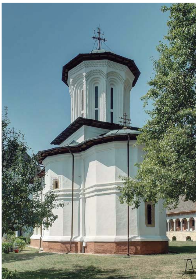
Vista sud-est, amb l'absis en primer pla. Fotografia LGM
