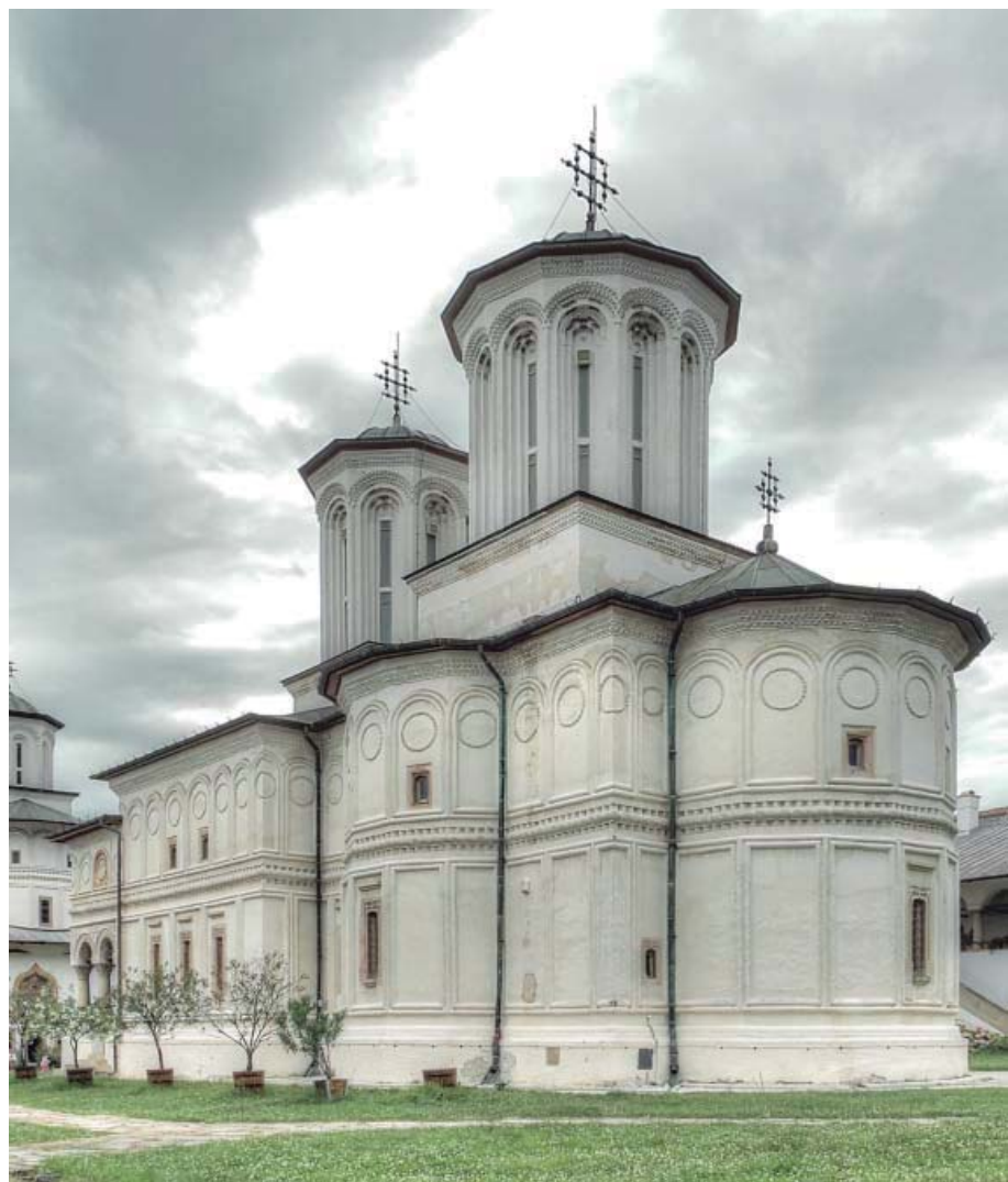
Vista sud-est de l'església. Fotografia: LGM
