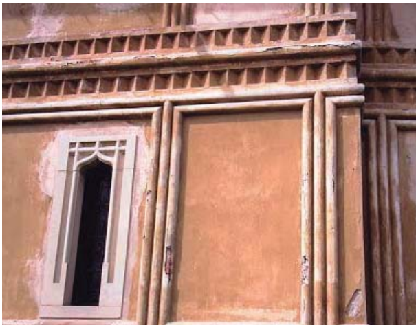
Detalls de l'ornamentació, amb marcs i motllures estucades i imposta amb maons en forma de dent de serra. Fotografia: LGM
