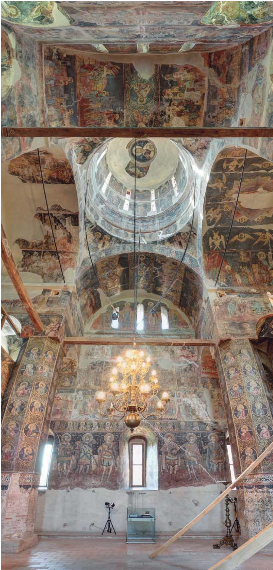
Panoràmica de la nau, amb visual cap a nord. Es poden observar els tres tirants de fusta, a la part superior dels pilars, que estableixen la base dels arcs. Fotografia: LGM
