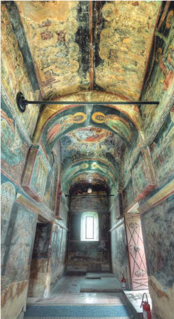
Vista panoràmica del naos, amb vista cap al sud. Fotografia: LGM
