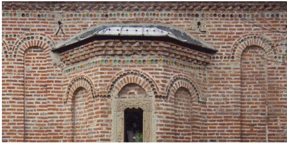
Vista frontal de l'absis lateral nord, amb el marc de pedra treballada i els discs de ceràmica esmaltada sota els ràfecs. Fotografia: LGM
