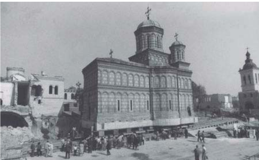
Fotografia durant el trasllat de l'església i el campanar (1985). Fotografia: Arxiu biblioteca escola d'arquitectura "Ion Mincu"
