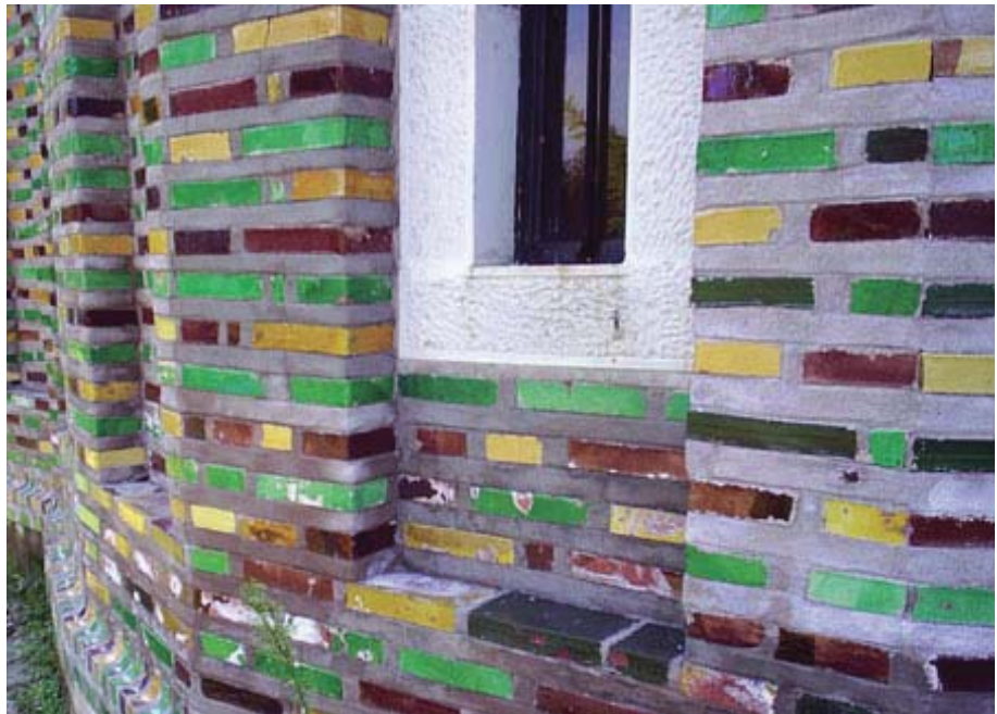
Detall de la façana on s'aprecien els maons esmaltats en tres colors i els marcs de pedra de les finestres.
