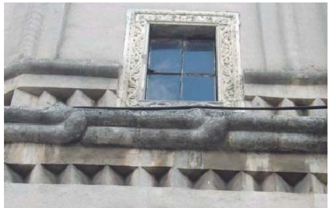
Detall de la motllura de la imposta, amb una sanefa en dent de serra. Fotografia: LGM
