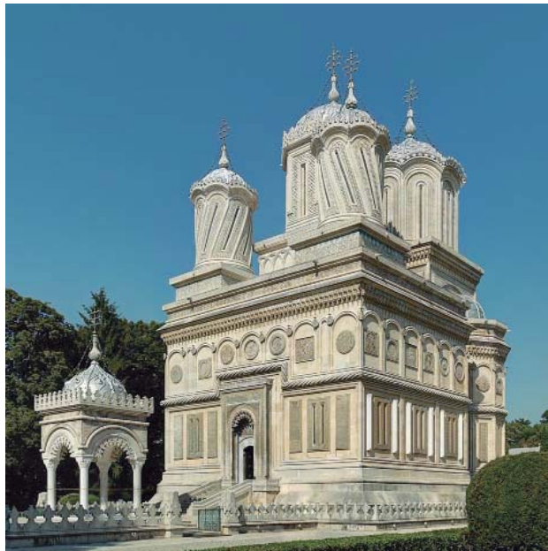
Vista sud-oest de l'església del monestir de Curtea d'Arges. Fotografia: LGM
