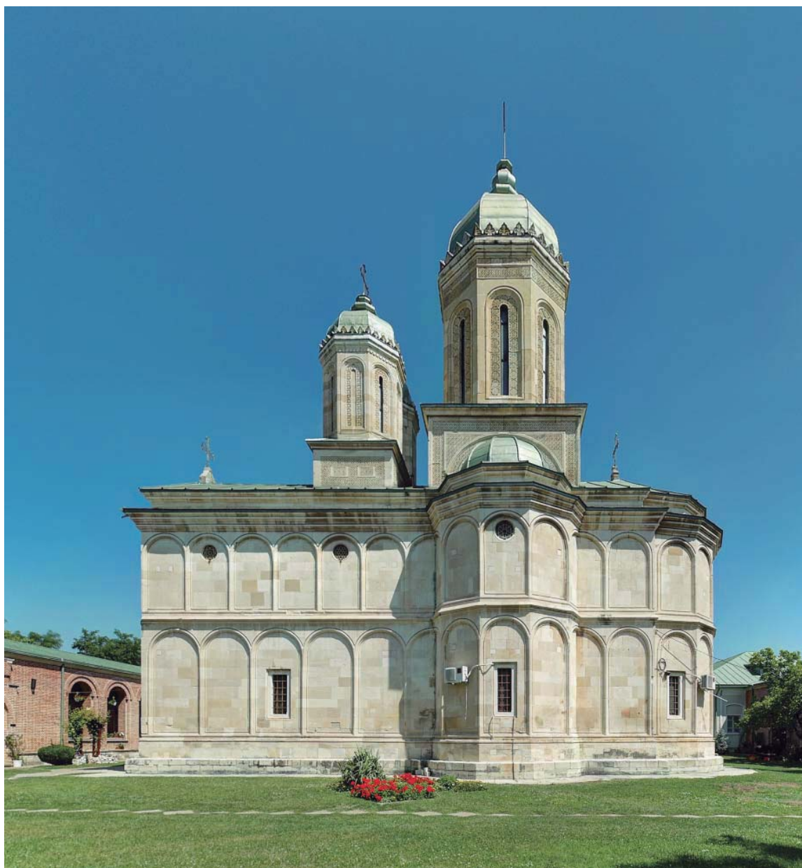
Vista frontal de la façana sud, amb la imposta, que divideix la façana en dos ordres, i la successió constant de les arcades cegues. Fotografia: LGM
