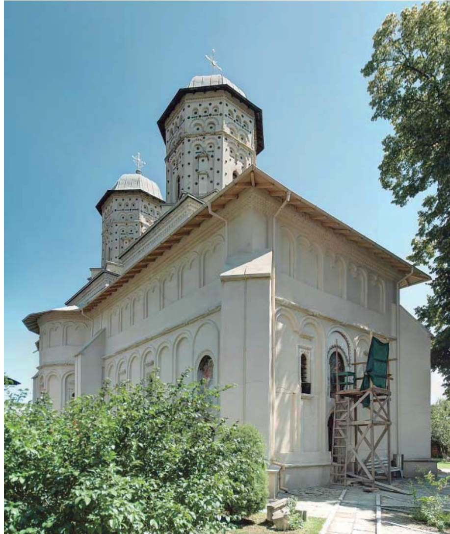
Vista nord-oest de l'església del monestir Stelea. Fotografia: LGM
