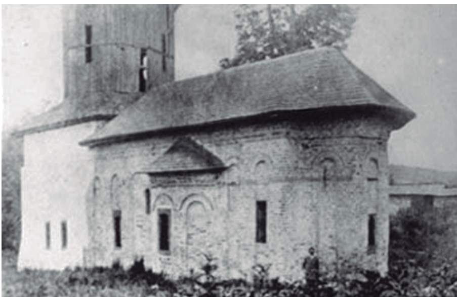
Fotografia anterior a la rehabilitació de l'any 1959, amb el campanar de fusta sobre el nàrtex i la coberta amb pendent accentuat. Fotografia: Arxiu biblioteca escola d'arquitectura "Ion Mincu"
