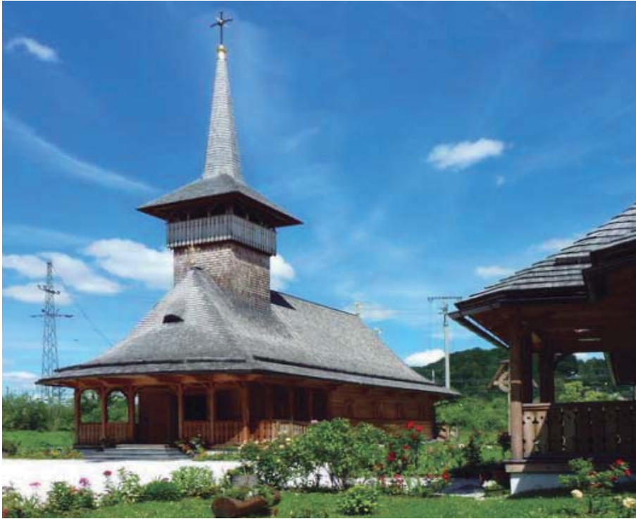
Església de la parròquia de Salzburg, a Àustria, construïda a Romania i transportada per peces a l'emplaçament definitiu. Fotografia: Parohia Salzburg .
