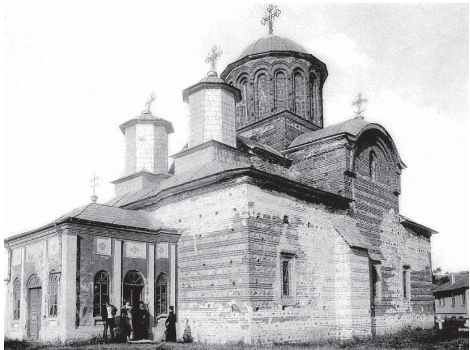
Fotografia de l'església amb els afegits del s. XIX: el porxo i els dos llanternons sobre el nàrtex.
