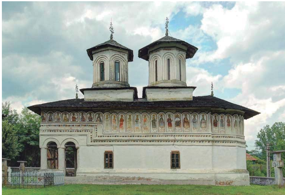
Vista frontal de la façana sud. Fotografia: LGM
