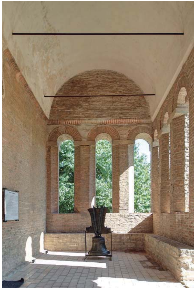
Panoràmica del porxo, cobert amb volta de canó. Fotografia: LGM
