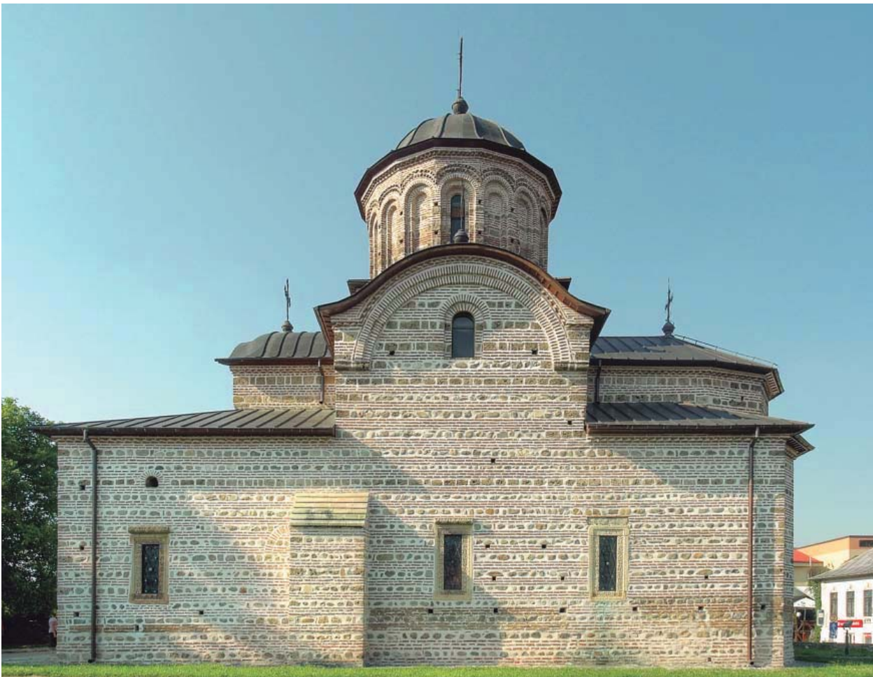
Vista frontal de la façana sud. Fotografia: LGM
