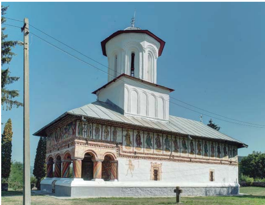
Església de Sant Nicolau a Coasta (Pausesti-Maglasi), amb la imposta en dues altures unida verticalment en el pas entre porxo i nàrtex. Fotografia: LGM
