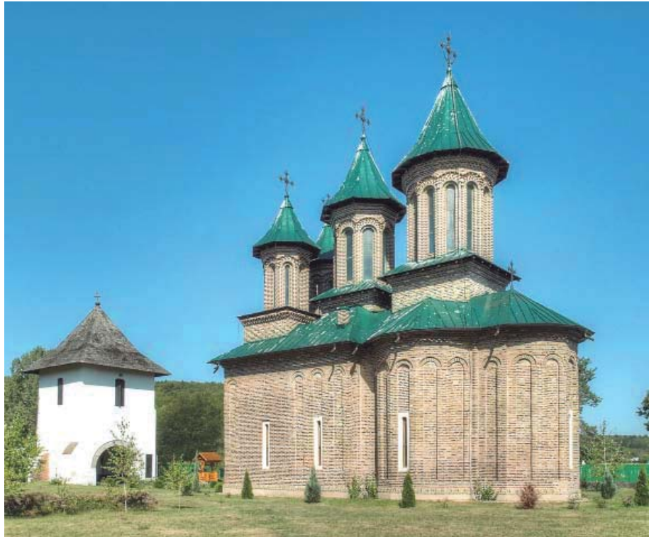
Vista sud-est de l'església del monestir de Cobia, amb la torre-campanar d'accés a la part esquerra de la imatge. Fotografia: LGM
