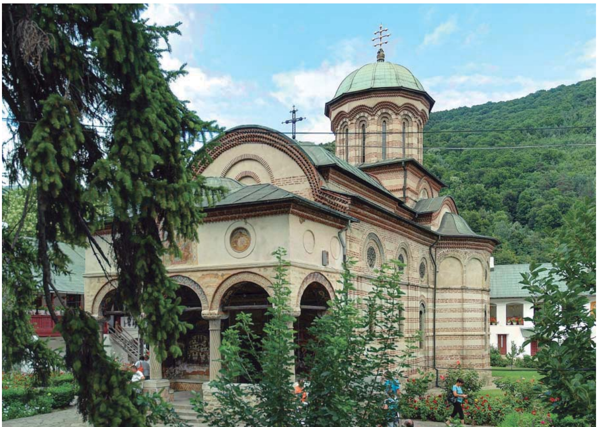
Vista sud-oest, amb el porxo afegit al s. XVIII. Fotografia: LGM
