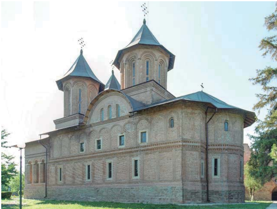
Vista sud-est, on s'observa, en l'ordre superior, les finestres afegides posteriorment, sense correspondència amb les inferiors. Fotografia: LGM
