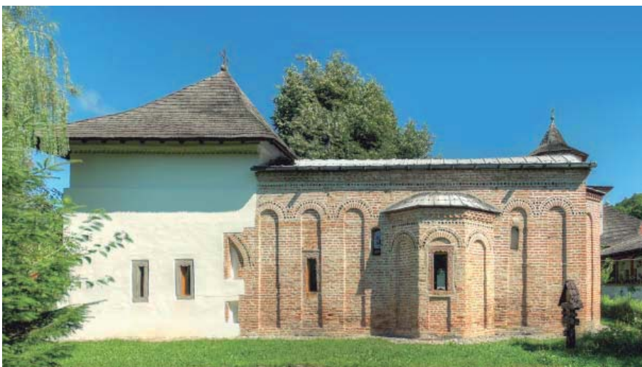
Vista frontal de la façana sud, amb la nau original d'obra vista, i el nàrtex reformat al s. XVIII a la part esquerra. Fotografia: LGM
