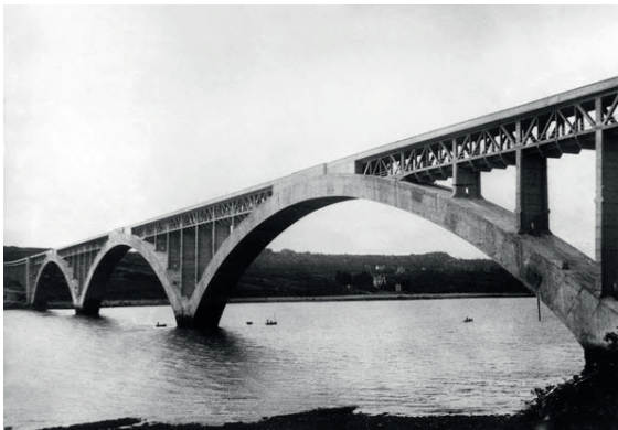
37-39 Proceso de construcción del puente de Plougastel, en el que Freyssinet volvió a aplicar la técnica utilizada en Orly de desplazar la cimbra, 1925-1930.
