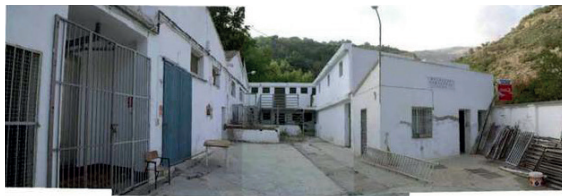
ISTA DEL PATIO INTERIOR DEL RECINTO DEL MATADERO CON LA BANCULA RAMPA INTERIORES DE ACCESO A PLANTA PRIMERA
