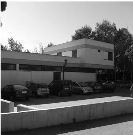
Fig. 38. Diferentes tratamientos y aperturas en función de la orientación para los pabellones de aulas del Colegio El Vedat. El pabellón de administración queda pautado por la alternancia de huecos y macizos. F: redibujo, AMM.
