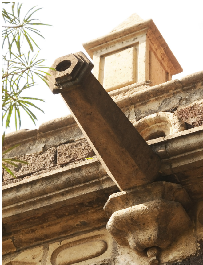
Detalle torrecillas, recortes galibateados y bajadas de agua en forma de cañón. Fotografía: Rafael López Castro.
