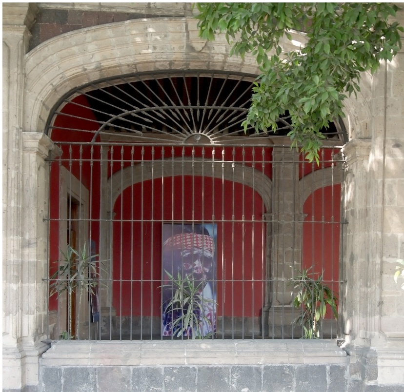
Detalles fachada principal (arcos rebajados y ventanas de jamba prolongada). Fotografía: Rafael López Castro.
