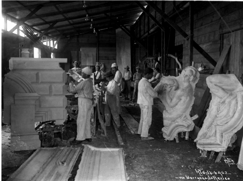
Realización del estucado para el pabellón de México en Río de Janeiro. Fuente: Archivo Carlos Obregón Santacilia, Dirección de Arquitectura y Conservación del Patrimonio Artístico Inmueble, DACPAI, Instituto Nacional de Bellas Artes México.
