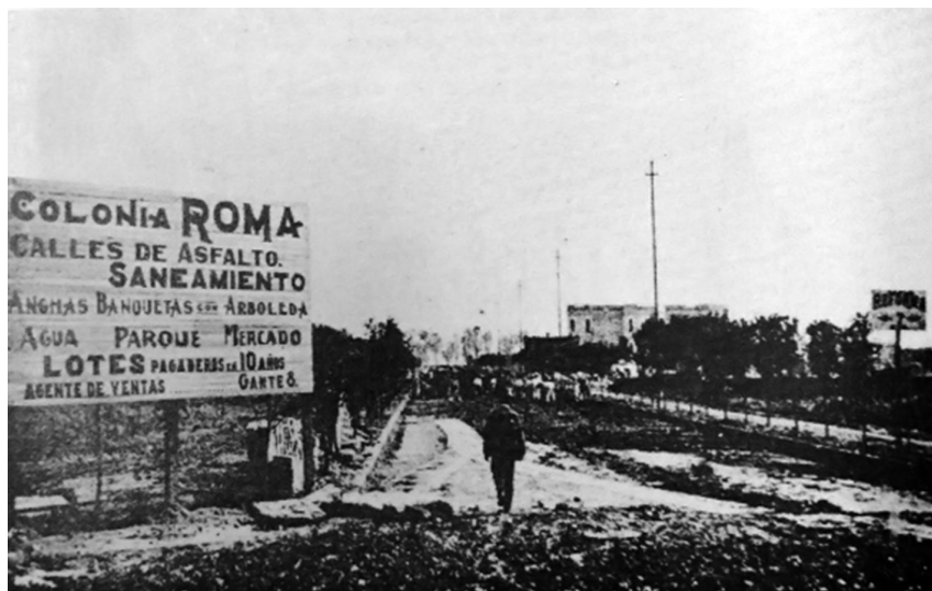
Foto Colonia Roma. Trabajos de urbanización en la calle Reforma 7. Fuente: Colección particular.
