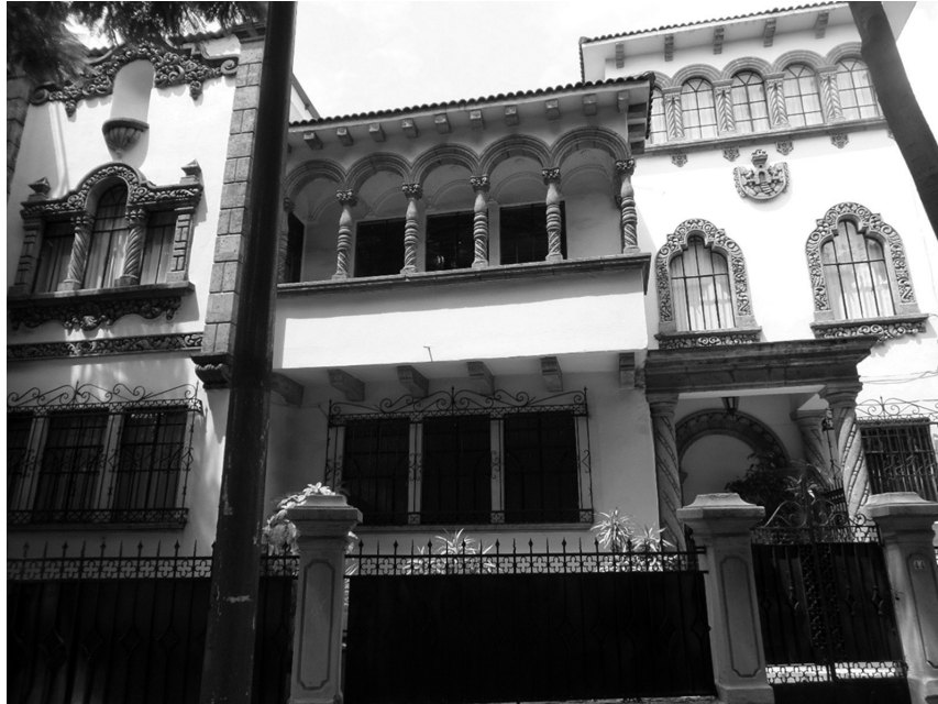
Casa privada en Polanco, calle Thiers. Fachada con columnas salomónicas, revestimiento de cantera sobreornamentada de formas orgánicas, nicho o venera coronada y balcones en herrería. Fotografía de la autora.
