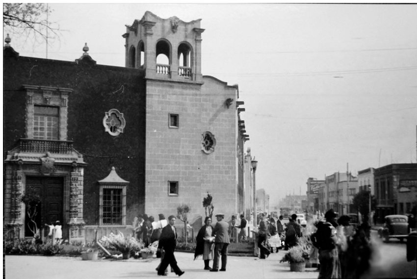
La fachada de la antigua Escuela Nacional de Maestros, ubicada en la esquina de la Calzada México-Tacuba y la Avenida de los Maestros. Fuente: Colección Villasana-Torres
