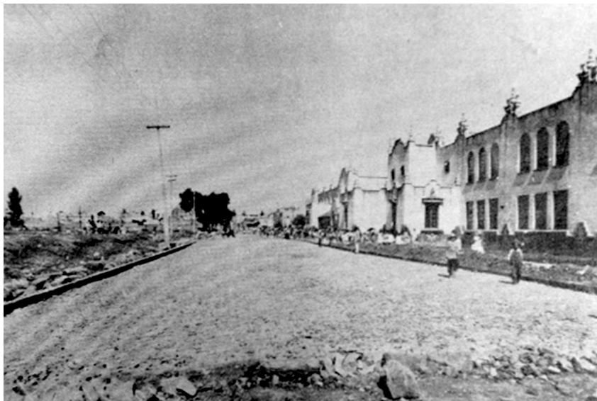
Foto Colonia Roma. Construcción de pavimento de macadam bituminoso frente al Centro Escolar "Benito Juárez", 1936. Fuente: Fototeca Instituto Nacional de Antropología e Historia.
