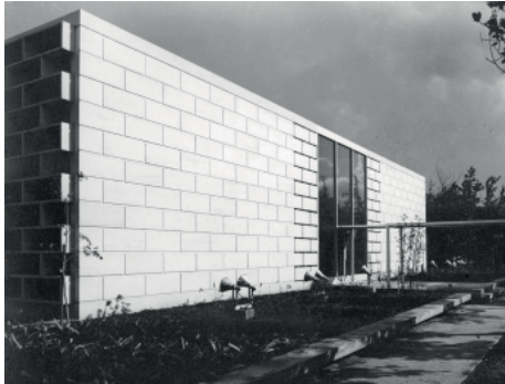
4.10- 4.11 Oficinas para Legisladores, anexo al Capitolio. San Juan. 1955. Toro Ferrer Arquitectos.
