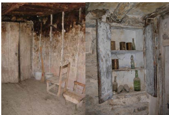
Envà de guix encofrat al pis. Armari encastat cuina.
