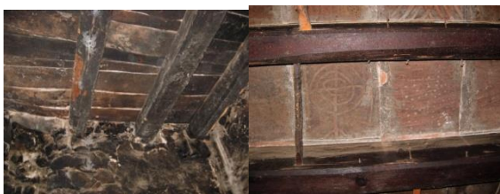
Sostre de fusta planta baixa. Sostre de rajols sala.
