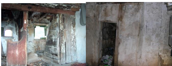
Escala a golfes. Pareds de guix encofrat.
