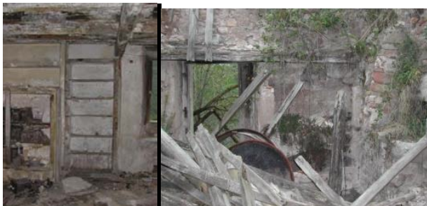
Armari encastat sala. Cuina NO
