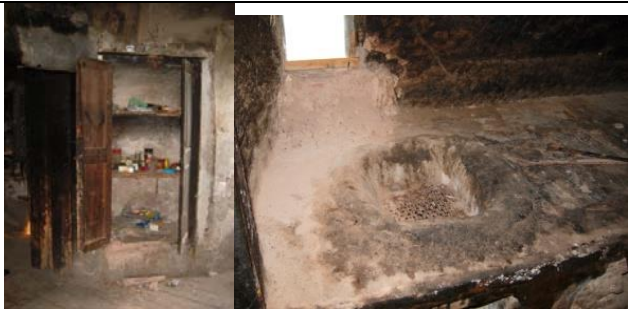
Armari raconer sala. Detall fogó de pedra cuina.
