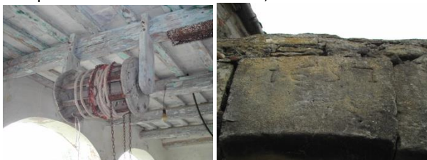
Corriola del pou de la cisterna. Porta del baluard.
