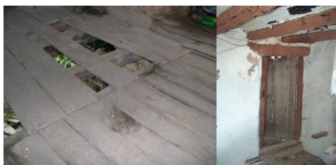
Paviment de la sala. Porta sala a cambra.
