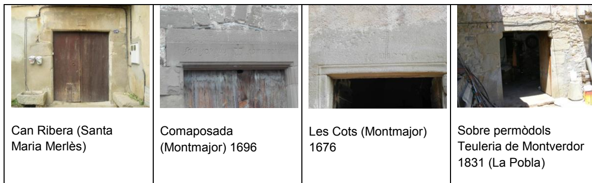
Imatge 46: Exemples de portes amb llinda de pedra.
