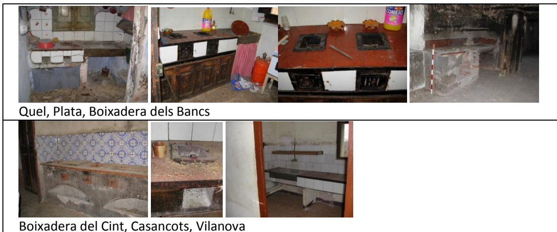
Imatge 87: Exemples de cuina de fogons sobre estructura d'obra.
