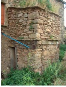
Imatge 64: Estructura exterior d'un forn situat al pis.
