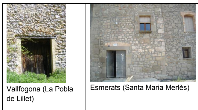
Imatge 47: Exemples de portes amb llinda horitzontal amb arc de descàrrega.
