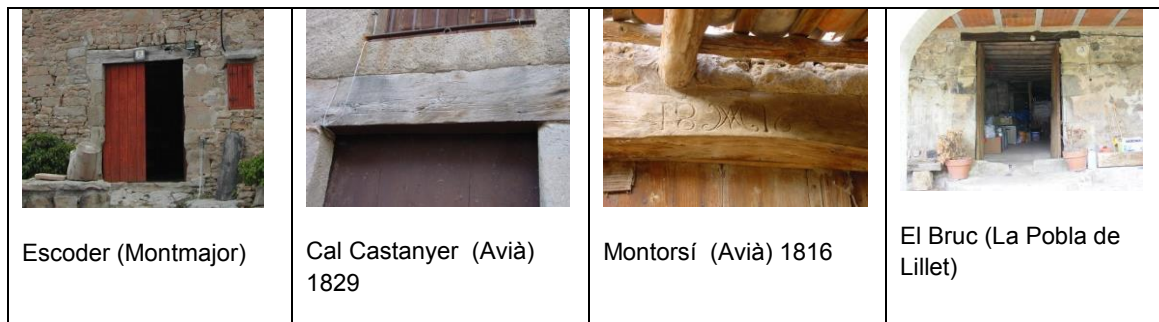
Imatge 45: Exemples de portes amb llinda de fusta.
