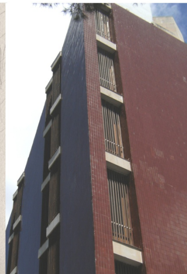
Extremo del ala este (foto superior AX) y croquis del extremo oeste, en el que se trata de adaptar la solución anterior. La imposibilidad de resolver ambos extremos del mismo modo debido al montacargas desembocó en la solución actual (foto inferior)
