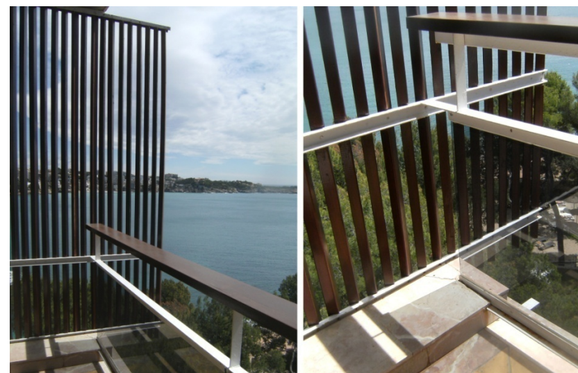
Fotos de la celosía, la viga de canto y la barandilla de las terrazas (arriba foto del AXC y abajo fotos actuales) que evidencian su independencia formal y su ligera construcción.
