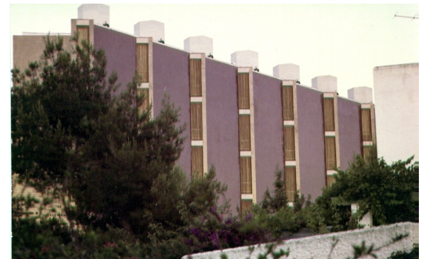
Alzado nocturno del hotel (negativo del alzado visado) donde las iluminadas aberturas del corredor muestran un cuerpo central simétrico flanqueado por alas semejantes, moduladas verticalmente. Foto del ala este hecha desde la terraza de la casa de Buadas.
