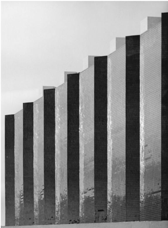
Estudios del Rascacielos Friedrichstrasse (arriba) donde el volumen de silueta quebrada se fragmenta en aristados paramentos verticales cuyos brillos, sombras y reflejos recuerdan la fotografía que Catalá Roca hace del ala este del Hotel de Mar (abajo).
