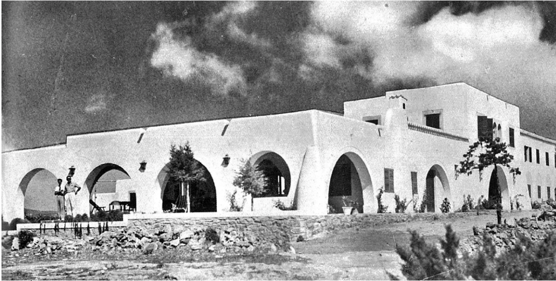
39 | 1954. Hotel de San Antonio Abad. Ibiza. Jose R. Pons "Hotel de San Antonio Abad", Revista Nacional de Arquitectura nº 154 (octubre, 1955), pg. 33-34
