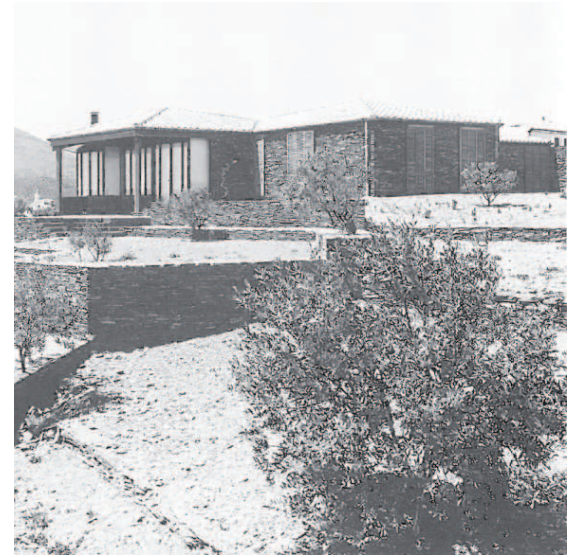
nº 10, Casa Romeu. Correa i Milà 1961
