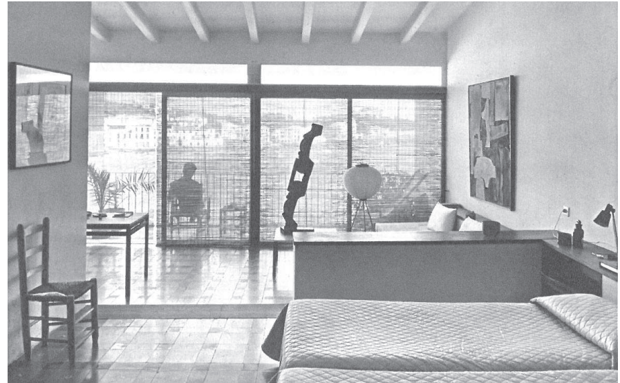
Paviment reaprofitat i cel ras de biguetes de fusta vistes en l'habitació de la planta segona
