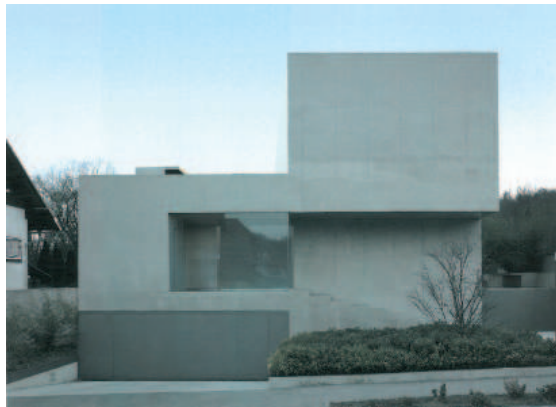
Casa unifamiliar, Bevk Perovic
