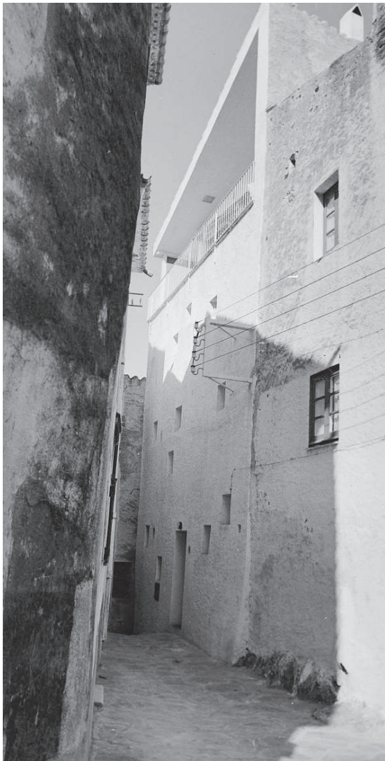
les plantes baixa, primera i segona són fruit de l'obra de reforma mentre que la tercera planta és una remunta i per tant obra nova
