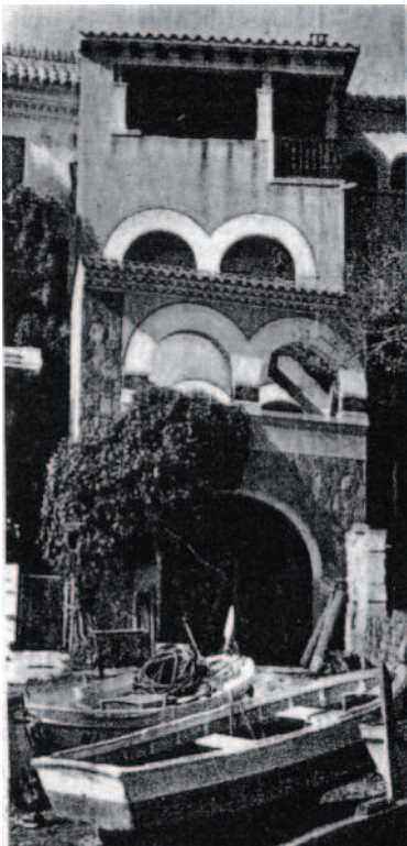
La façana abans de la reforma de Harnden i Bombelli
