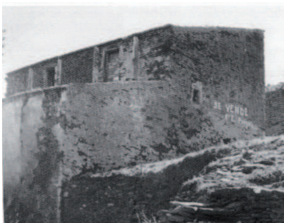
La casa Bombelli abans i després de la reforma
