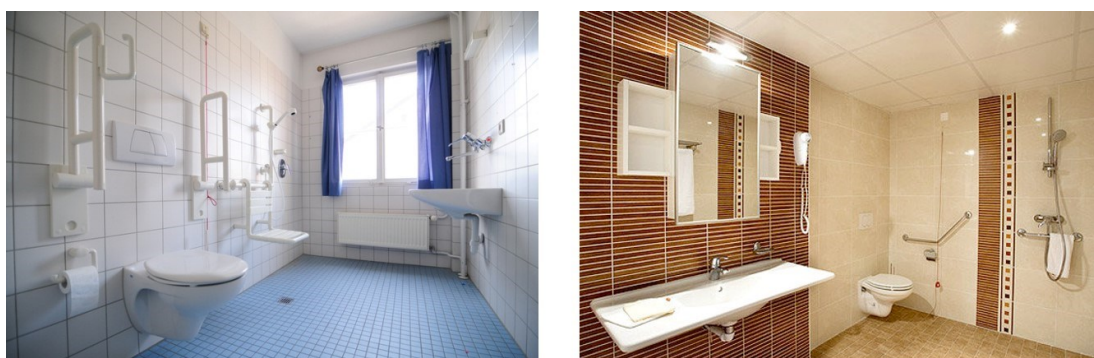
Figure 29 A gauche, salle de bain adaptée portant les « stigmates » de la dépendance. A droite, salle de bain avec adaptation intégrée aux situations de handicap (Cérèse & Eynard, 2014)
