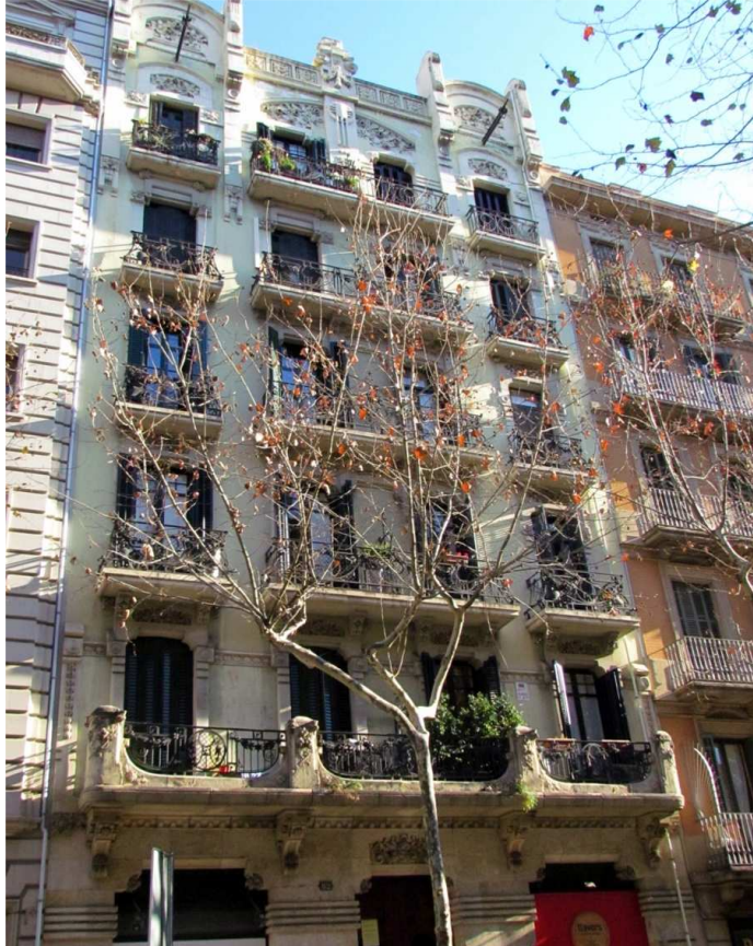
Fig. IV.CXVIII. Fachada de la Casa Cucurella (C/Villarroel 62).
