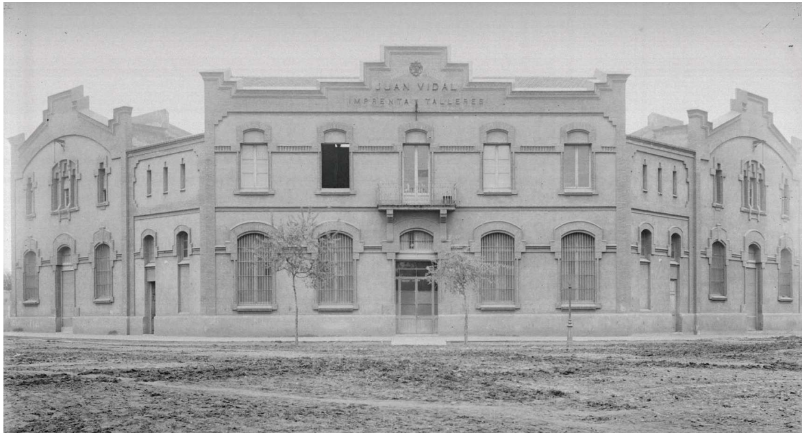
Fig. IV.LXXI. Imprenta y Talleres Vidal tras la conclusión de los trabajos, c.1912.
