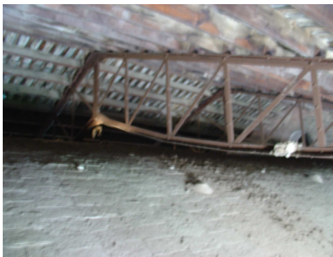
Fig. IV.CXXIV. Detalle de los dos cuchillos parabólicos o de “ala de mosca” de Torras i Guardiola incorporados sobre el presbiterio en el proyecto de reforma y nueva cúpula por Doménech y Estapá [Foto.: Consultoris BIS Arquitectes , 2004].
