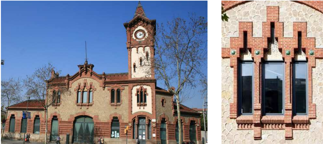
Fig. IV.LXXVIII. (izq.) Imagen actual de la fachada principal exterior de La Magoria / (drch.) Detalle de la ventana trigeminada central sobre el acceso al “Gran Hall”.
