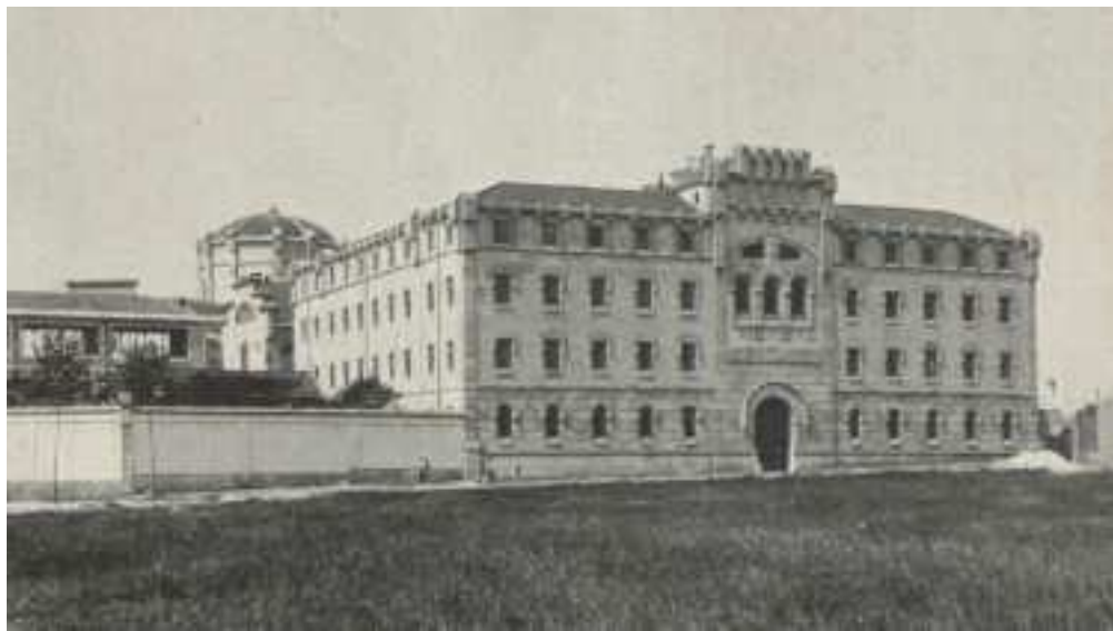
Fig. IV.XIV. Vista de la fachada principal del cuerpo “de la Administración” en 1904 [“Nueva Cárcel Celular; Barcelona” (1904), Art. cit., p.151].
