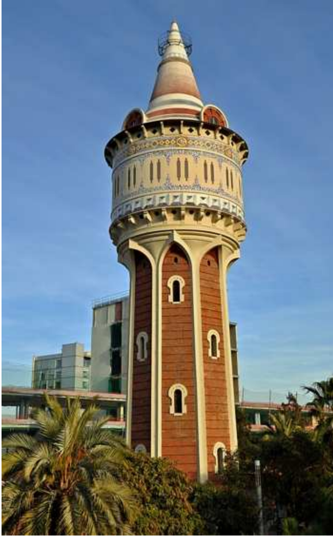
Fig. IV.LXVIII. Vista actual de la torre de las aguas de la fábrica del gas de la Barceloneta, José Doménech y Estapá.
