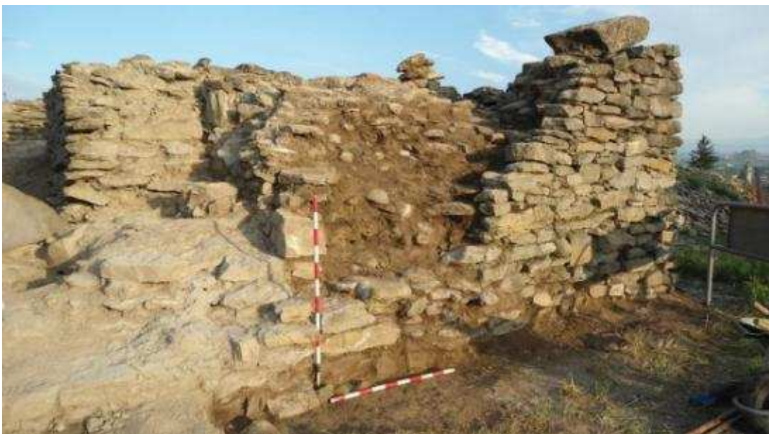
Fig. 38: aspecte de la Torre 6 des del sud-est. A la part central de la imatge, aspecte del mur est de la torre (UE 01006) caigut en "rentadora". A la dreta, part recrescuda als anys 60 (UE 01011). Fotografia Albert Pratdeaba, Àngels Pujol.
