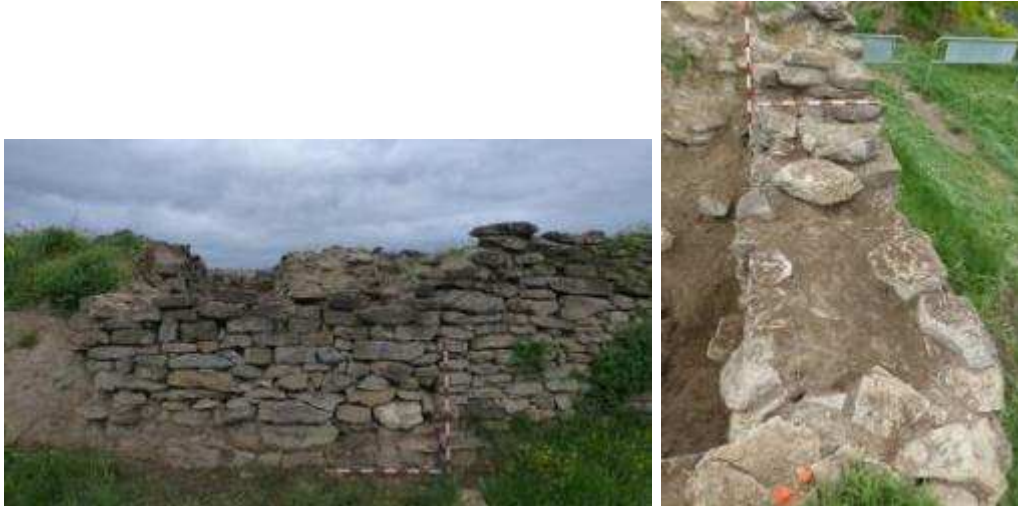
Fig. 36: aspecte del mur UE01002. A l'esquerra, vist des de l'oest; a la dreta, vist des del sud. Fotografia: Albert Pratdesaba, Àngels Pujol.
