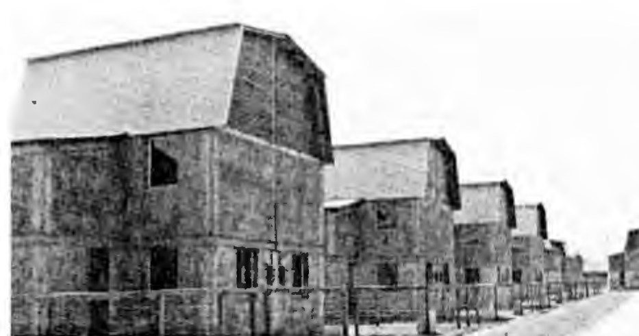
LICITACION SERVIU REGION METROP. N° 84-7-7 EX-CAMPAMENTO EL ROTO CHILENO COMUNA SAN RAMON EMPRESA CONSTRUCTORA CONST VIVIENDAS ECONOMICAS MAGRI FIGUEROA SDA 350 VIVIENDAS PRODUCTOS MASISA EMPLEADOS TABIQUE MASISA PANEL 24MM ARQUITECTOS: HORACIO BORGHRESI - ALFREDO DONOSO
