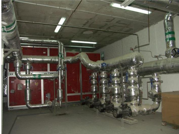
[III.17]. Climatizador y circuitos hidráulicos (en planta técnica, bajo cubierta).
