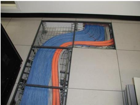
[VI.19]. Suelo técnico y trazado horizontal de cableado estructurado.
