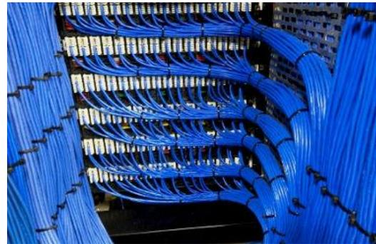
[VI.20]. Armario de telecomunicaciones con conexiones de cableado estructurado desde cada punto de servicio.
