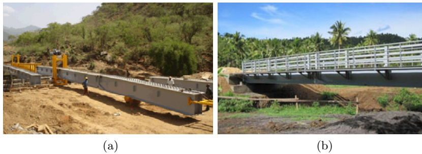
Figura 6.10: Alternativa de puente Ibridge (Unibridge)
