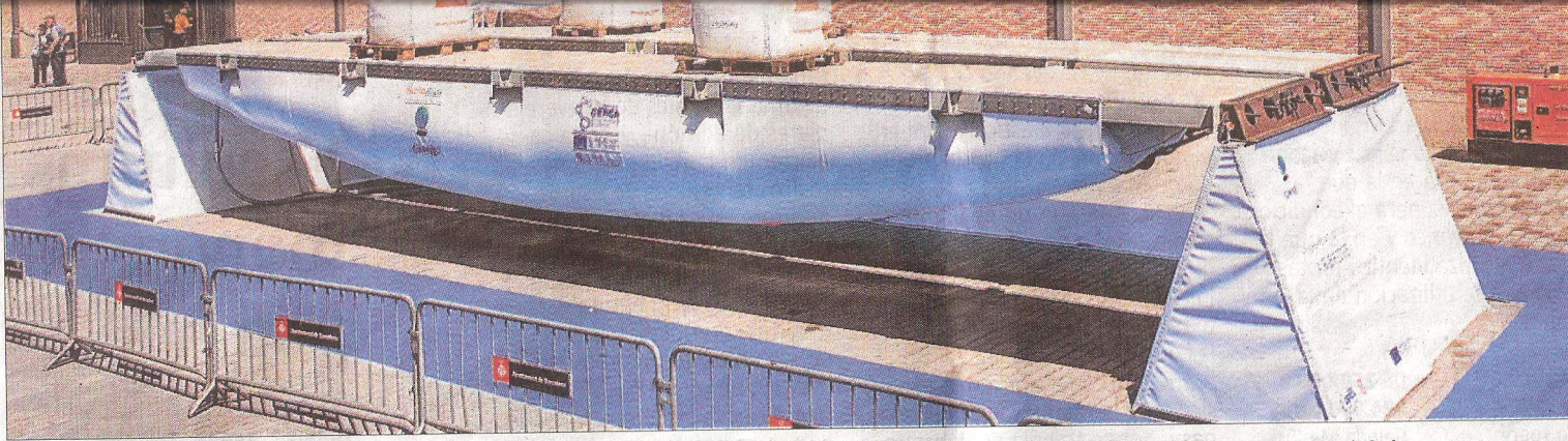
El puente Air-Bridge está formado por una superficie de material compuesto ligera y por dos tubos inflables en forma de vigas situados en la parte inferior
