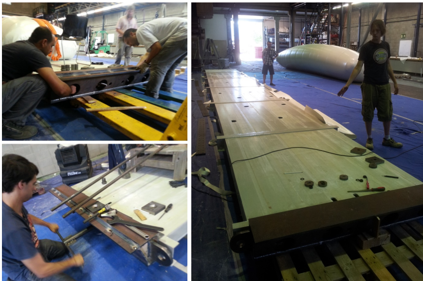
Figura 5.60: Colocación de apoyos metálicos y apriete de barras
