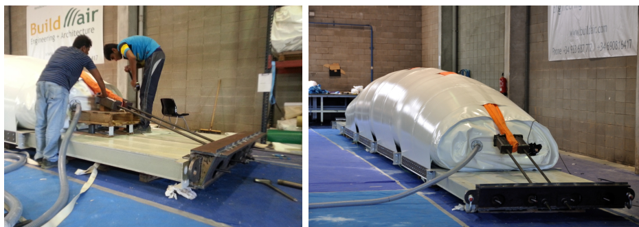
Figura 5.63: Fijación de la eslinga a los extremos de la viga
