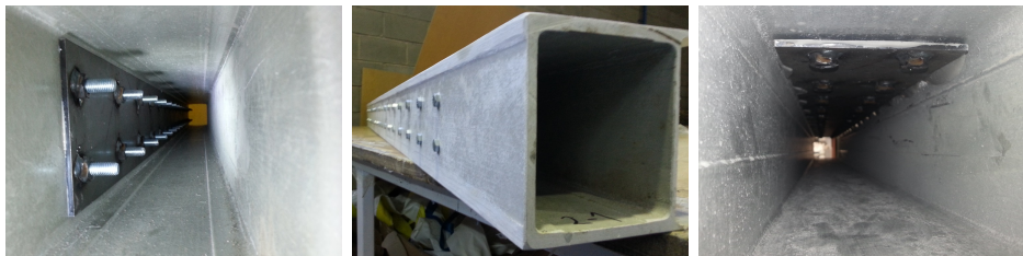
(c) Pegado en el interior y fijación mediante tornillos hasta endurecimiento (d) Pegado en el interior y fijación mediante tornillos hasta endurecimiento (e) Endurecimiento de la resina y extracción de tornillos
