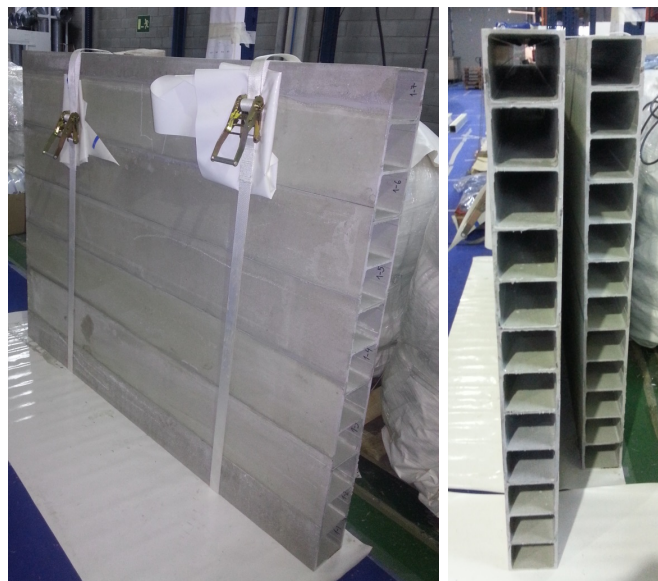
Figura 5.29: Pegado de los perfiles FRP machihembrados para formar el cuerpo central de los paneles del tablero
