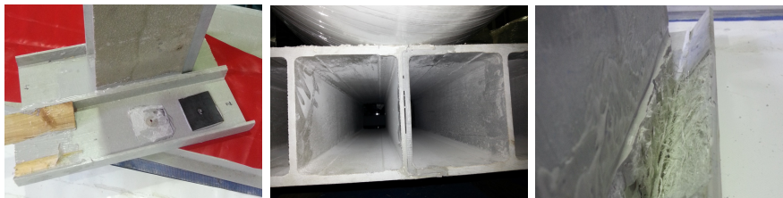
Figura 5.16: Adherencia entre materiales y pruebas de carga de los perfiles FRP pegados
