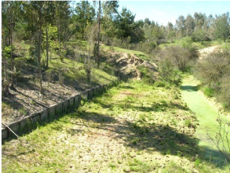
Figura 3.17. Microcuenca 3 antes del incendio. Esta microcuenca se caracteriza por sus laderas y áreas erosionadas (a diferencia de las anteriores). Las empalizadas y los sacos de contención eran las principales obras llevadas a cabo en este sector. Fuente: Captación propia.
