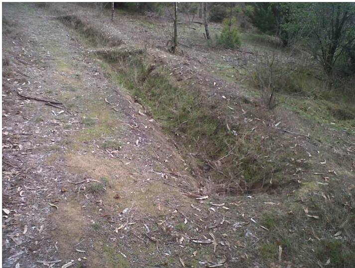
Figura 6.14. Zanjas de Infiltración en la microcuenca 2. A través de esta técnica se regulan los volúmenes de escorrentía superficial y se almacenan o “cosechan” aguas para el riego. Fuente: Captación propia.
