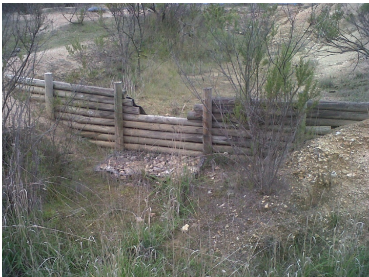
Figura 6.16. Dique de poste en la microcuenca 3. Un dique es una obra relevante en el control de erosión en zonas de cárcavas al regular el flujo hídrico y contener los sedimentos transportados. En la imagen se observa el dique con la disposición de los postes y un dissipador (construido con piedras de río) en la zona inferior que tiene por función impedir el impacto directo del flujo de agua durante los eventos pluviométricos. Fuente: Captación propia.
