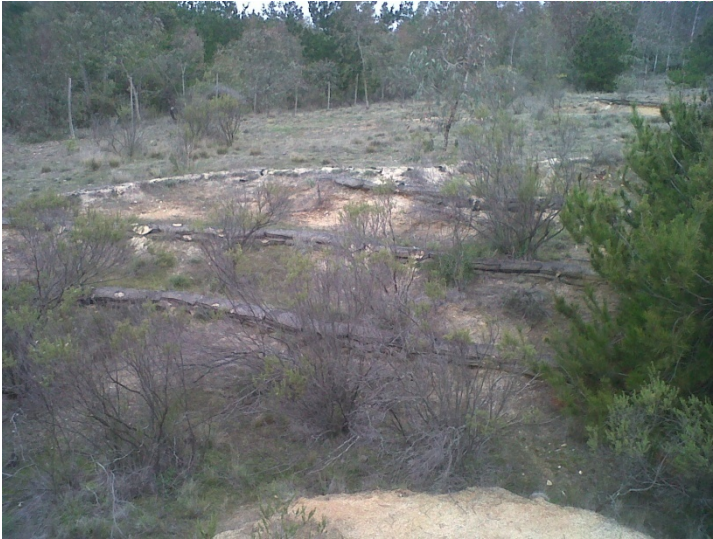
Figura 6.21. Tratamiento lineal de sacos en la microcuenca 3. Este tratamiento resulta apropiado en laderas de pendientes moderadas con erosión del tipo laminar y lineal incipiente. De sencilla ejecución y bajo costo. Fuente: Captación propia
