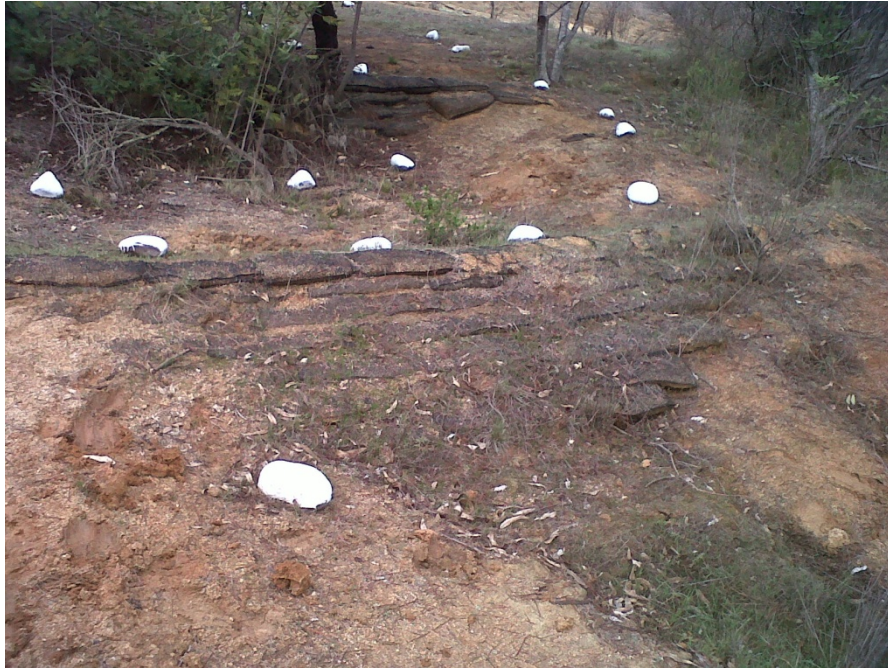
Muro de sacos rellenos. Se construyó en la ladera de exposición oeste (W) de la microcuenca, Los sacos se rellenan con tierra del mismo lugar y en forma escalonada para mayor resistencia a los procesos erosivos
