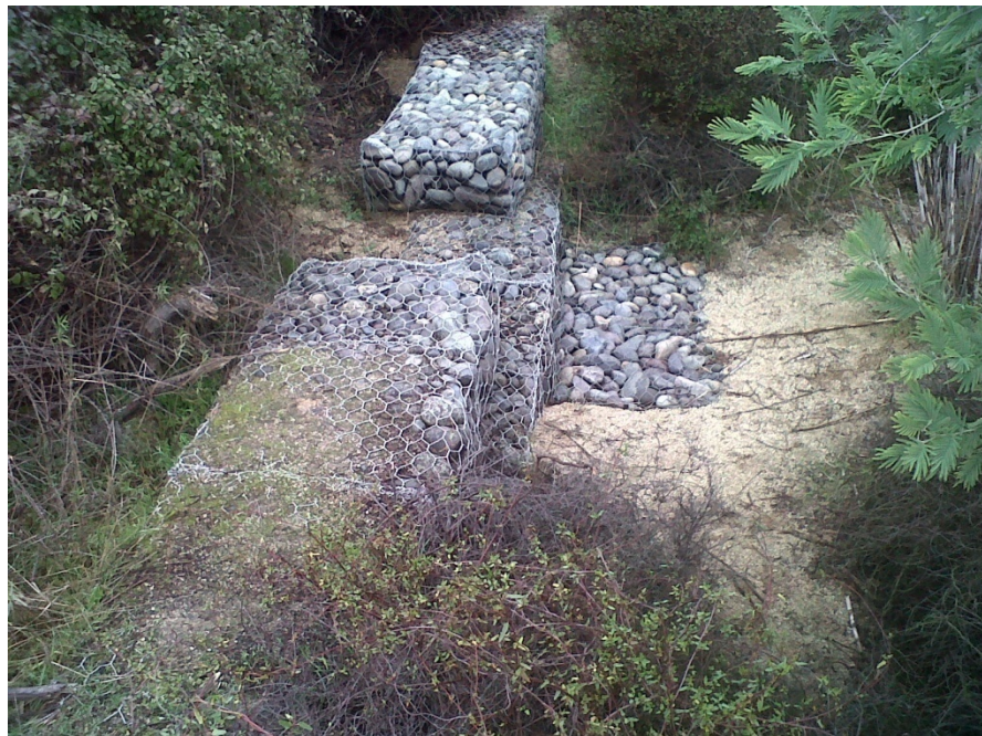
Dique de estructura gavionada. Construido con piedras de río y malla metálica, el gavión ha impedido la erosión disminuyendo la energía cinética al flujo de agua. Esto ha permitido el desarrollo de flora en los alrededores de la obra.
