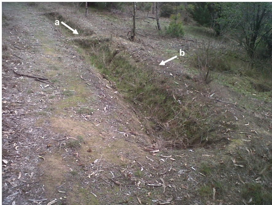
Zanjas de infiltración. Se construyeron en la zona superior de la ladera oeste de la microcuenca 2; básicamente para permitir la infiltración de agua así como para impedir la erosión por escorrentía. Cuenta con un tabique (a) que separa una zanja de otra y un camellón (b) que impide el desborde de la zanja durante los eventos pluviométricos.
