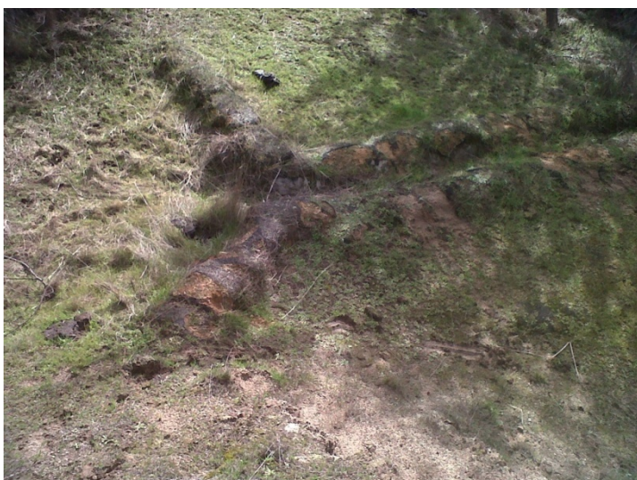
Figura 6.23. Canal longitudinal de sacos de tierra en la microcuenca 2. Este tratamiento se utiliza para la desviación de escorrentía superficial hacia cauces y como elemento de apoyo a otras obras. Fuente: Captación propia
