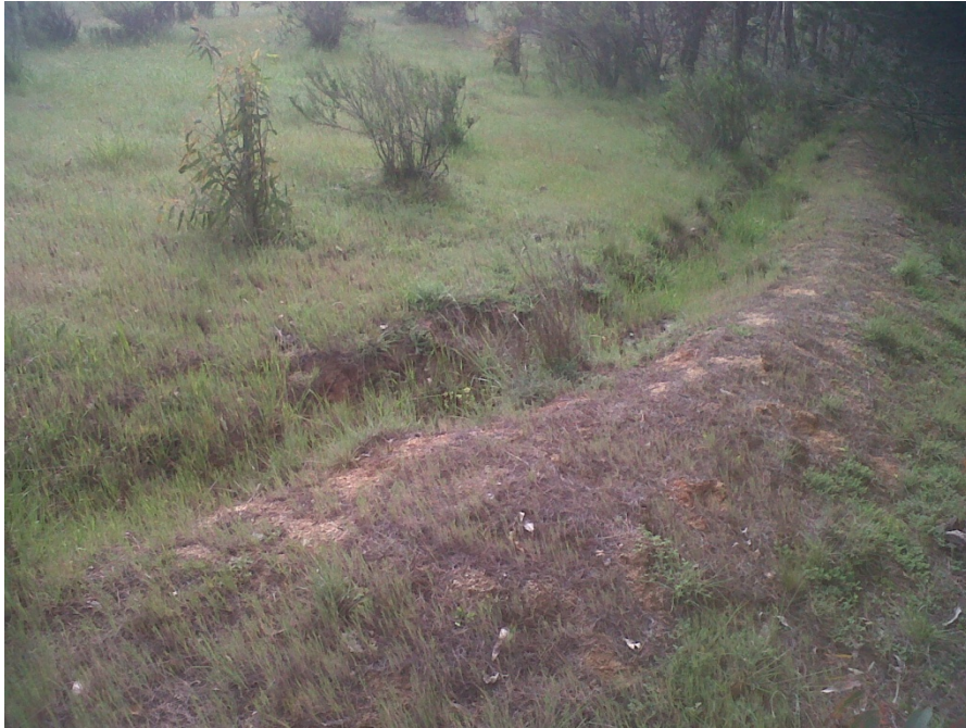
Canal de desviación. Este sistema fue construido en la ladera de exposición sur en la microcuenca 2 en el límite con la microcuenca 4.
