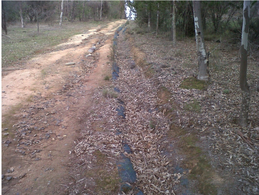
Canal longitudinal de sacos. Construidos en la zona baja de la ladera en que se construyó la obra anterior, tiene por objetivo conducir la escorrentía superficial a orillas del camino durante los episodios pluviométricos para evitar la erosión en la zona baja de la ladera.
