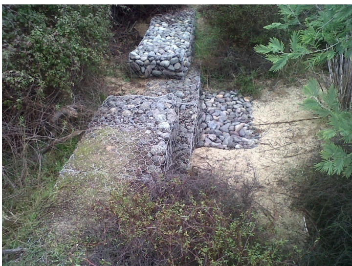
Figura 6.17. Estructura gavionada en la microcuenca 2. Este tratamiento permite regular los flujos hídricos en cauces medianos y mayores, debido a su gran resistencia en períodos de crecidas. Fuente: Captación propia.
