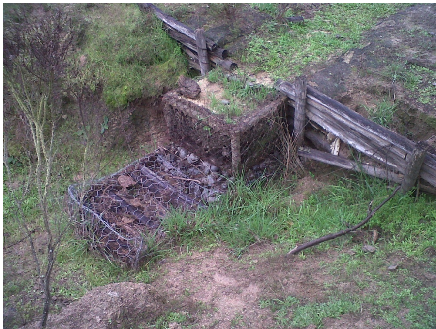
Dique de postes con disipador y acumulador de sedimentos. Construido en una cárcava al sur del dique anterior en la misma ladera, este dique cuenta con un acumulador de sedimentos en el sector de salida y un disipador en la zona baja.
