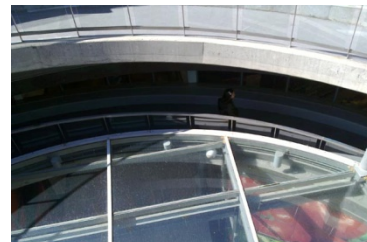
Figura IV. 258 – Claraboyas en estructura metálica y vidrio. Fuente: Pedro Bento
