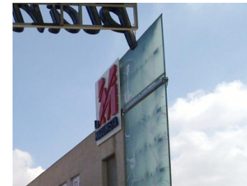
Figura IV. 44 – Esquina del edificio central formada por un cerramiento acristalado con juegos de luces y colores
