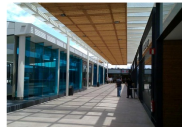
Figura IV. 125 – Fachadas del Lucernario y restaurantes en vidrio. Fuente: Pedro Bento
