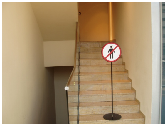
Figura IV. 267 - Señal de pasaje prohibido Fuente: Pedro Bento
