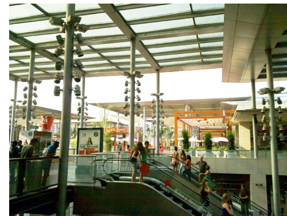
Figura IV. 301 - El paseo. Comunicación entre el foodcourt y las terrazas. Fuente: Pedro Bento
