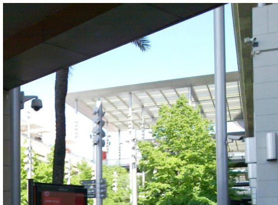
Figura IV. 260 - Cámaras de video-vigilancia Fuente: Pedro Bento
