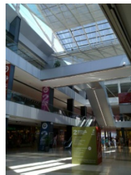
Figura IV. 124 – Cubierta inclinada a 30° en estructura de aluminio y de luna templada 10 y vidrio. Fuente: Pedro Bento
