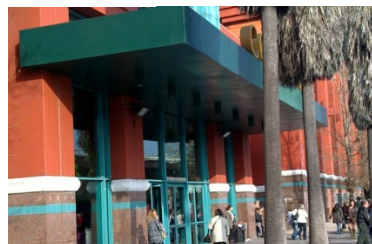
Figura IV. 193 - Paredes Exteriores en Hormigón Pintado y enriquecidas con losas de granito y elementos cerámicos Fuente: Pedro Bento
