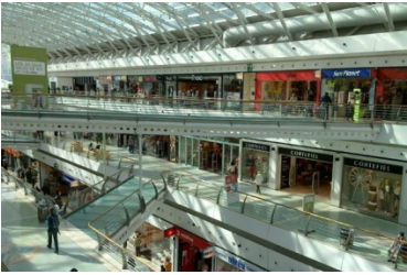
Figura IV.223 – Estructuras metálicas y vidrio Fuente: Pedro Bento
