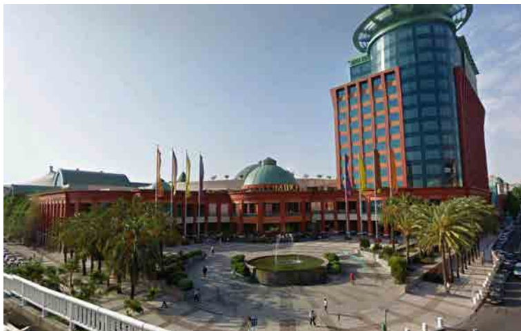
Figura IV. 129 – Vista de la Plaza de la Fuente a partir de la Av. Lusíada. Fuente: Pedro Bento
