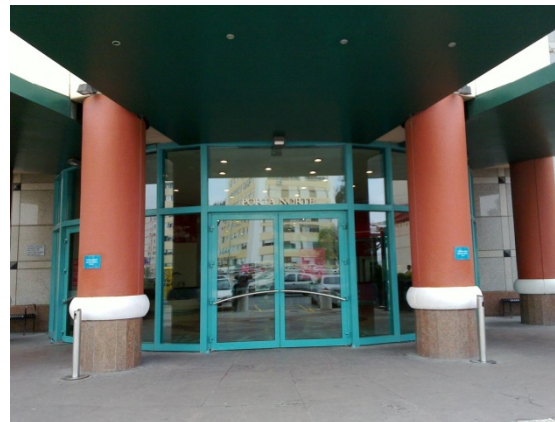
Figura IV. 281 - Puertas de Apertura Manual y Automática Fuente: Pedro Bento
