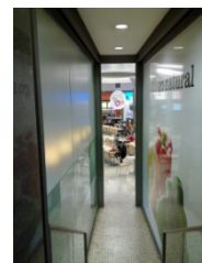
Figura IV. 255 – Paredes construidas a través de Estructuras metálicas y vidrio. Fuente: Pedro Bento
