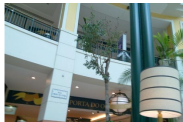
Figura IV. 194 - Fachadas interiores en hormigón revocadas y pintadas en color blanco y amarillo. Fuente: Pedro Bento
