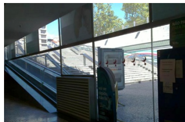
Figura IV. 252 – Resina Epoxi simulando el empedrado portugués en el interior y empedrado portugués en el exterior. Fuente: Pedro Bento
