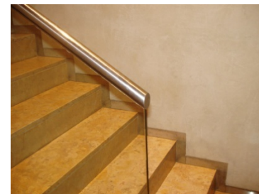
Figura IV.85 – Barandillas en vidrio con pasamanos en acero inoxidable. Fuente: Pedro Bento
