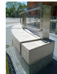
Figura IV. 259 – Barandillas revestidas de losas de mármol de Pero Pinheiro y estructura metálica y en cristal Fuente: Pedro Bento
