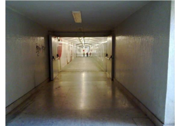
Figura IV. 294 - Puerta a prueba de fuego en el pasillo de metro Fuente: Pedro Bento
