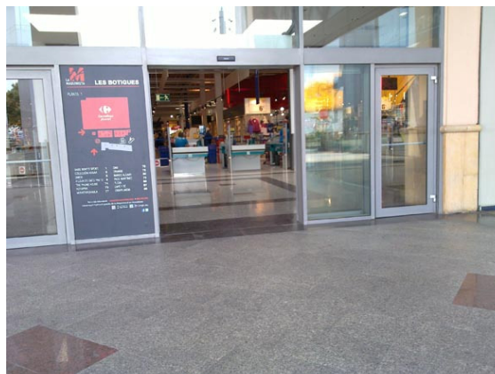
Figura IV. 263 - Puertas de Apertura Automática Fuente: Pedro Bento
