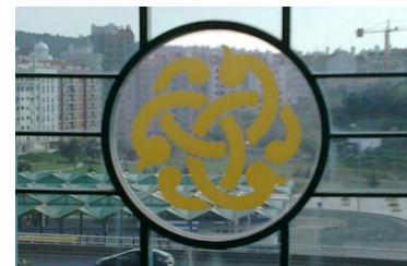
Figura IV. 195 - Detalle de las fachadas de los vestíbulos de entrada en estructura de aluminio pintado y vidrio templado. Fuente: Pedro Bento
