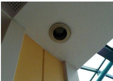
Figura IV. 197 - Falso Techo en Pladur con luminarias encastradas Fuente: Pedro Bento
