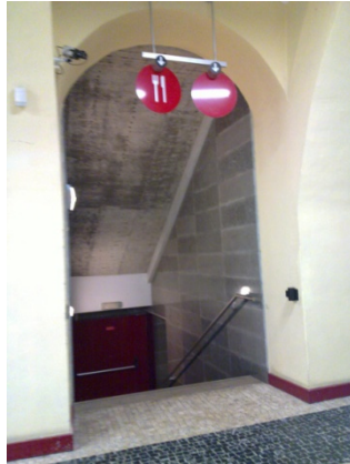
Figura IV. 290 - Cámaras de video-vigilancia Fuente: Pedro Bento
