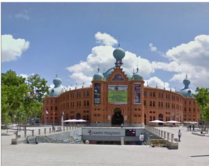
Figura V. 21 - Fachada Principal Av. República Fuente: Google
