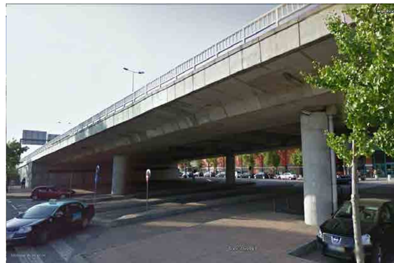
Figura V. 63 - Cruce desnivelado de la Avenida do Colegio Militar con Avenida Lusíada. Fuente: Google Earth
