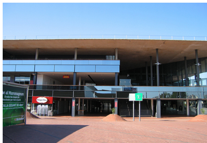
Figura V. 12 - Fachada Posterior (Cines) Fuente: Pedro Bento
