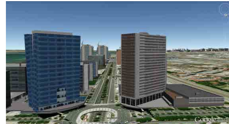
Figura V. 68 - Refuerzo del eje vertebrador del Parque das Nações - Avenida Dom Joao II. Fuente: Google Earth
