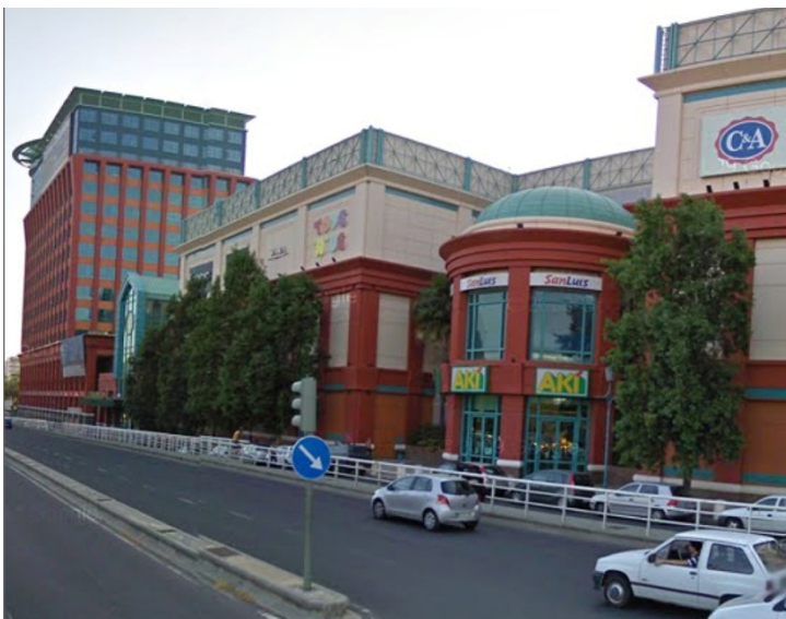
Figura V. 13 - Fachada Sureste Av. Colégio Militar (2ª Circular)
