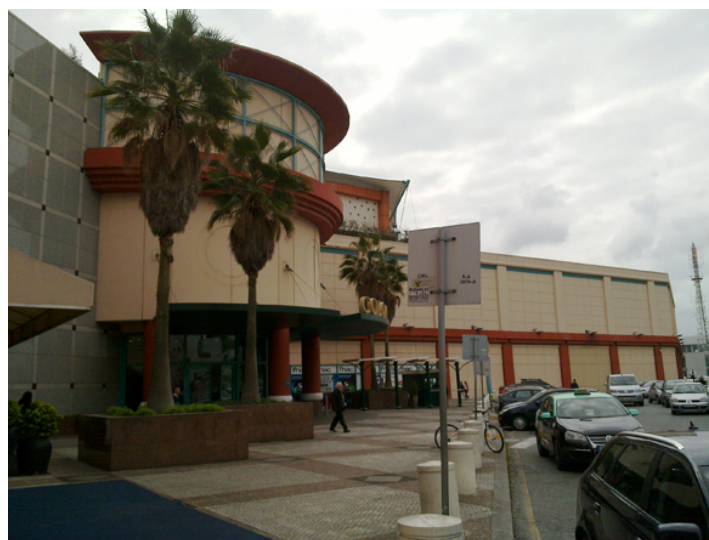
Figura V. 40 - Entrada Norte Fuente: Google
