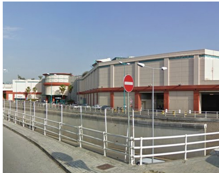
Figura V. 15 - Fachada Av. Dos Condes de Carnide
