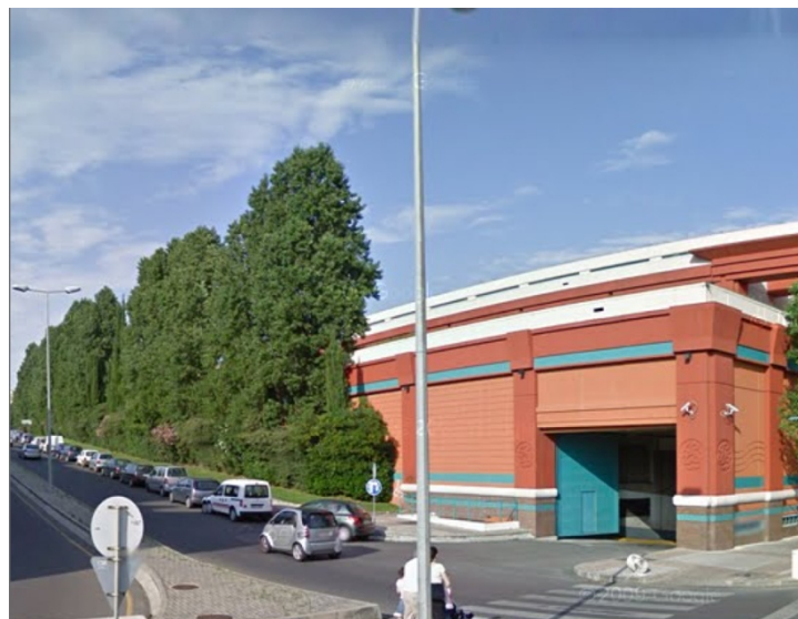
Figura V. 14 - Fachada Calle Poente
