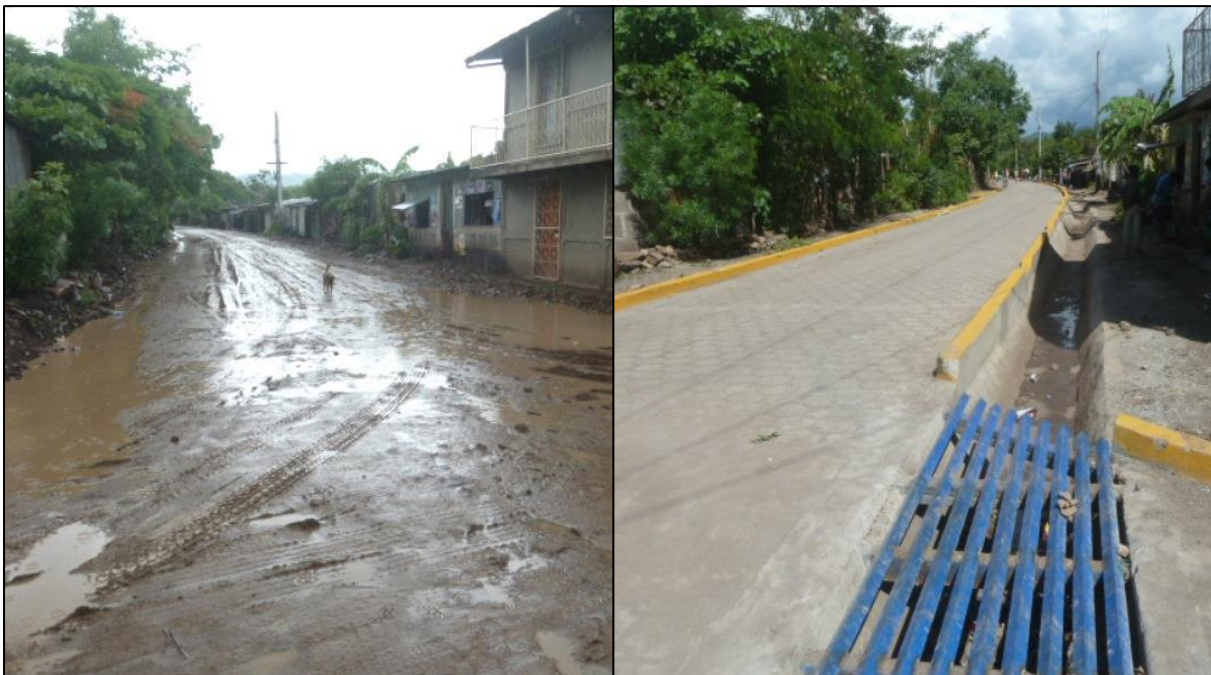
Antes y después del proyecto de mejoramiento integral del barrio Paz y Reconciliación, Matagalpa.
