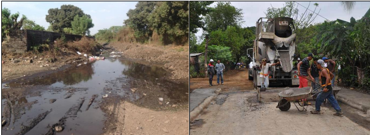
Imagen 28. Situación original del acceso al barrio (izquierda) y ejecución de las obras con pavimento de concreto hidráulico (derecha) en el barrio El Limonal, Chinandega.
