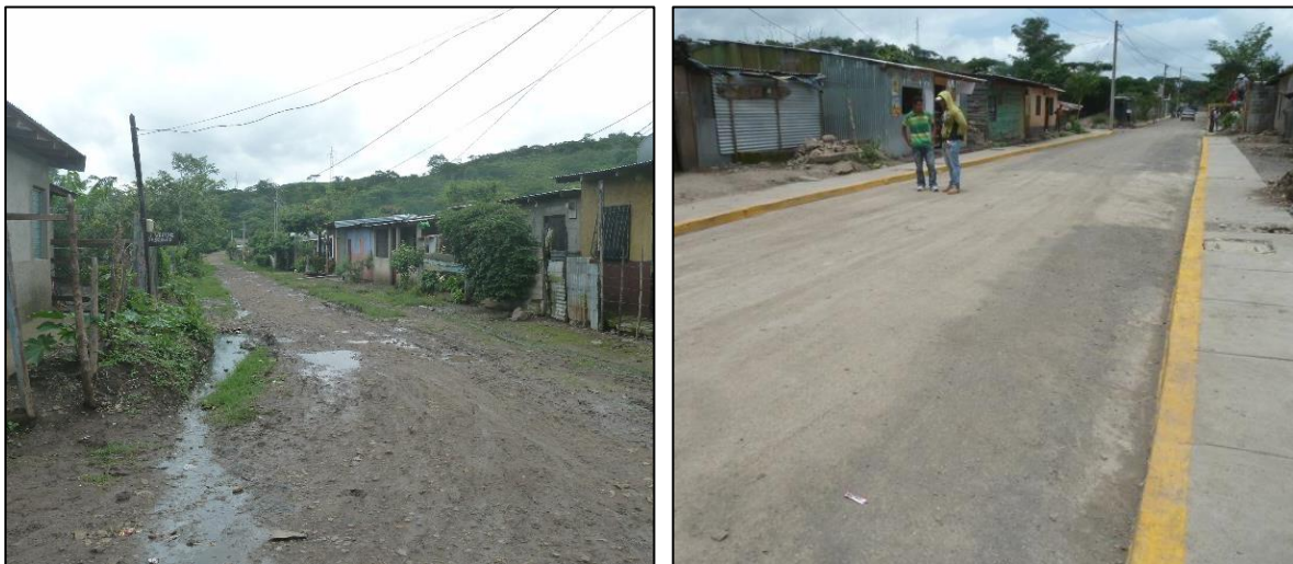
Imagen 30. Antes y después de las obras de pavimentación con UNICAPA en el barrio Diriangén, Jinotega.
