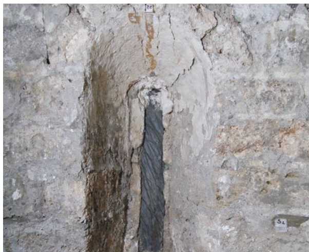
Primera decoració de junta de carreus. Finestra central de la part inferior de l'absis. La decoració de rejuntament és visible en el mur a la part dreta i esquerra de la finestra. ©Mercè Marquès
