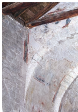
Costat esquerra del frontis. Fragment de pintura que arrencada, després de la restauració de l'any 2001. © Foto Robert Ramos
