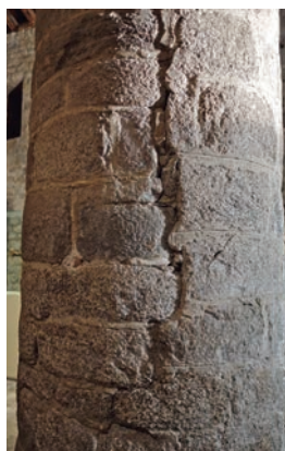
Unió de les dues fases constructives de la columna 6. ©Mercè Marquès
