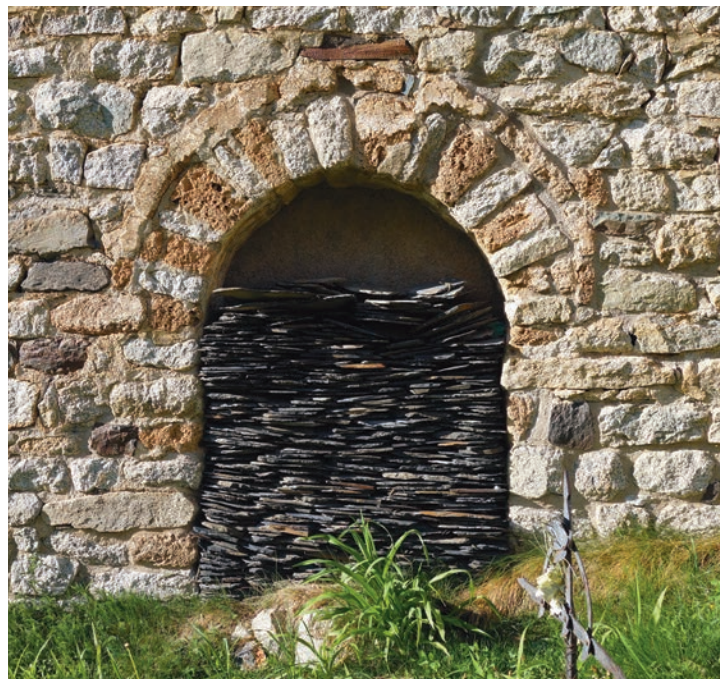
Construcció de l'arc de la porta. Únicament les pedres de travertí tenen la forma de tascó. ©Mercè Marquès
