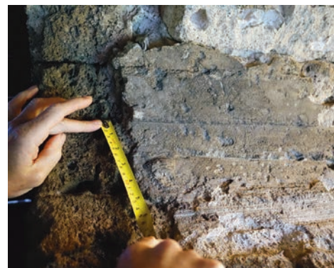
Empremta de la fusta del cindri de construcció de l'arc sobre el morter. Arc del campanar de l'església. © Mercè Marquès
