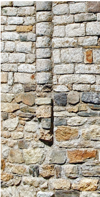
Absis central. S'aprecien els dos models de fàbrica del mur. © Mercè Marquès
