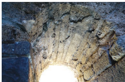
Morter d'encofrat del sistema de construcció dels arcs de la torre. ©Mercè Marquès
