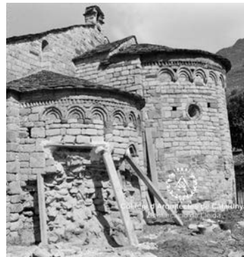
Arranjament de l'absidiola sud. Obres de la DGBBAA mitjan del s. XX. Foto Arxiu Ferrant COAC Demarcació de Lleida
