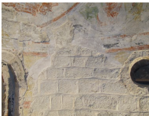
Segona decoració de junta de carreus. L'aparença blanca del mur és deguda a què l'arrebossat aplicat sobre la decoració de junta i sobre els carreus ha tenyit la superfície amb el color blanc de la calç del morter. ©Mercè Marquès
