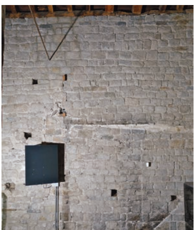
Zona dreta del mur sud. Queden les empremses del desaparegut cor de l'església, eliminat a finals del s. XX. ©Mercè Marquès
