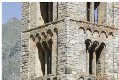
Nivell 3. Es conserva capes d'arrebossat i restes de policromia en les arcuacions i intradossos dels arcs. © Foto J. Giribet. Calidos
