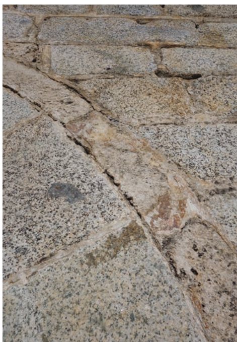
Veure detall de la decoració de l'extradós de l'arc. Per sobre del lliscat s'ha aplicat una ratlla gruixuda de color mangra (façana oest). ©Mercè Marquès
