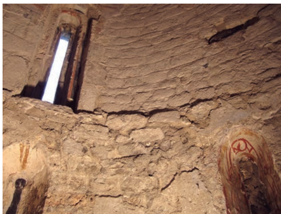
Zona del centre de l'absis, al costat dret de la finestra. La disposició de les pedres mostren l'arrencament d'un sostre possiblement en forma de volta. ©Mercè Marquès
