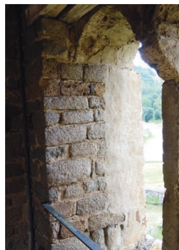
Aplicació de l'arrebossat en els intradossos de les finestres. Quan l'intradós és ample, s'aplica l'arrebossat únicament en la part exterior. ©Mercè Marquès
