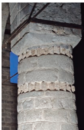
Columna 5. Ornament de 2 frisos de dent de serra , ubicats en tot el perímetre de la columna. ©Mercè Marquès
