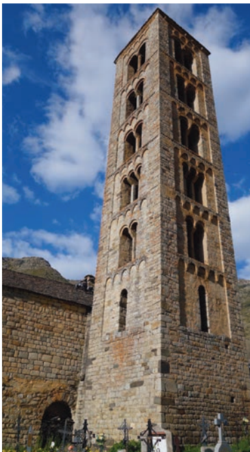
La construcció del campanar, oculta el brancal de la porta que pertany a la primera fase constructiva de l'església. ©Mercè Marquès
