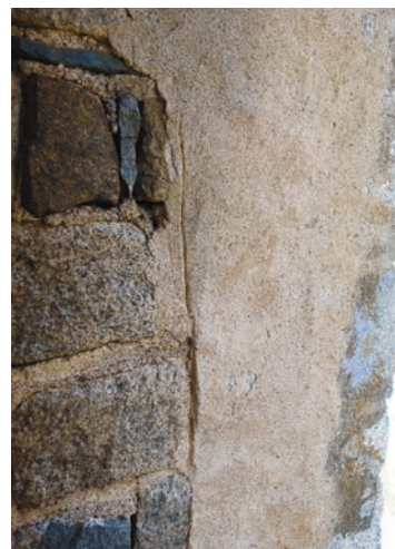
Retall de la capa d'arrebossat. Al costat esquerre, es veu el tractament de les juntes dels carreus. ©Mercè Marquès
