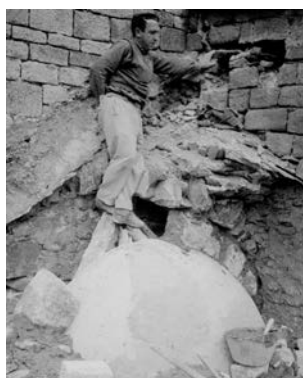
Detall de la reconstrucció. Disposició dels carreus de granit sobre el cindri. Foto Arxiu Ferrant COAC Demarcació de Lleida
