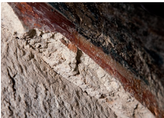
S'ha detectat una zona amb doble capa d'arrebossat. La capa inferior pot correspondre a un estrat decoratiu anterior al de la decoració del Mestre de Taüll. © Foto R. Maroto CRBMC
