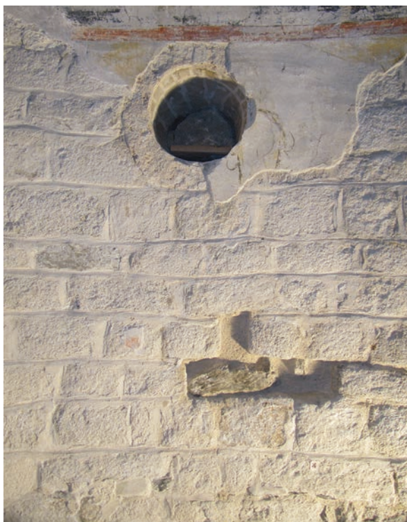
Segona decoració de junta de carreus al parament vertical de l'absis central. Tal com es mostra a la imatge, la pintura mural del mestre de Taüll està aplicada sobre la decoració de junta. ©Mercè Marquès
