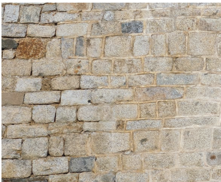
Detall de la ratlla blanca pintada sobre la decoració de junta. El morter aplicat en la junta, està curosament retallat per fer un rejuntament molt precís sense envair la pedra (façana oest). ©Mercè Marquès
