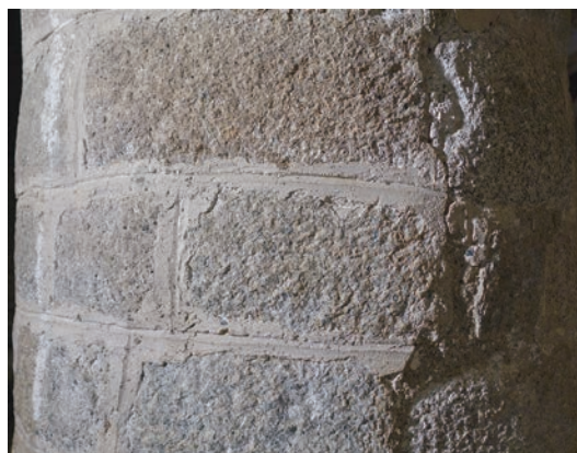
Rejuntat de la part posterior de la columna 6. No hi ha pinzellada blanca i es marca amb profunditat la incisió de l'eina per fer un dibuix prim de la junta. ©Mercè Marquès
