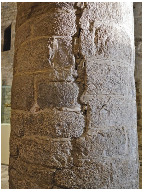
Columna 6. Construïda en dues fases. Zona d'unió de les dues construccions amb diferent disposició de carreus i diferent junta d'unió. ©Mercè Marquès
