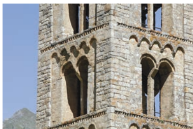
Nivell 4. Es conserva capes d'arrebossat i restes de policromia en les arcuacions i intradossos dels arcs. Foto © J. Giribet. Calidos
