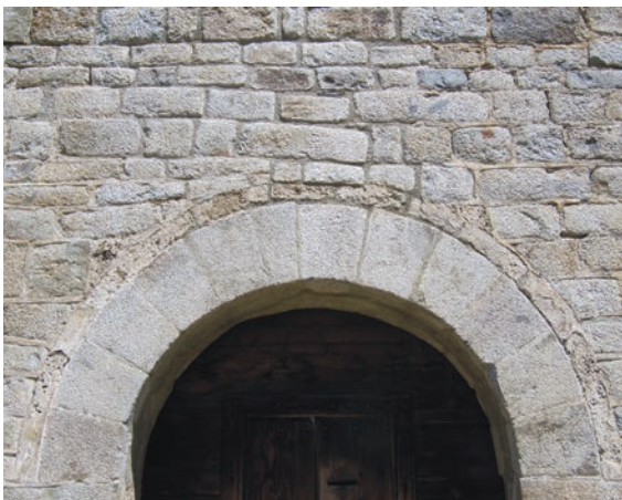
Aspecte de la part superior de la porta d'entrada. S'ha conservat l'aspecte original a la dreta i a l'esquerra de l'arc, però en la part superior es pot veure l'efecte de ciment gris com redibuixa negativament la trama constructiva. ©Mercè Marquès
