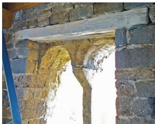
Reforç estructural del moment de la construcció mitjançant una biga de fusta únicament en les finestres del 2n nivell. ©Mercè Marquès
