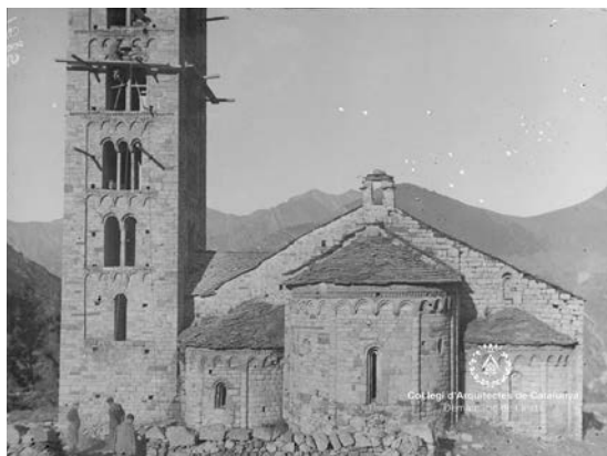
Aspecte de la façana est i de la torre del campanar, abans de realitzar les obres estructurals per part de la DGBBAA. Anys 50 segle XX. Algunes de les finestres de la torre estaven paredades així com les finestres inferiors de l'absis central i l'absidiola nord que presentava esquerdes estructurals importants. Foto Arxiu Ferrant COAC Demarcació de Lleida
