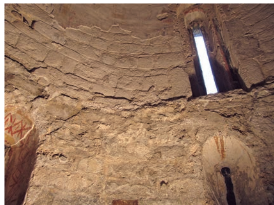
Zona del centre de l'absis. La forma del mur, per sota de la finestra central, insinua l'inici de la construcció d'una volta. ©Mercè Marquès
