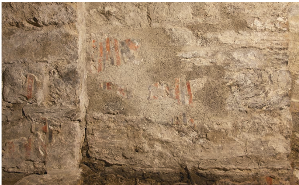
Part inferior de la zona presbiteral sud i de l'absis. Encortinat amb drap de paret que està ubicat en l'absis i en el primer arc triomfal tocant l'absis. © Mercè Marquès
