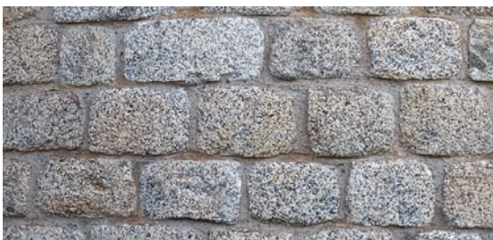
Tipus de construcció regular amb pedra granítica a l'absis de l'església. © Mercè Marquès
