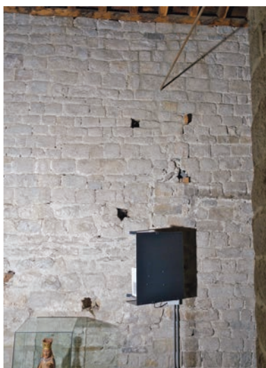
Zona central del mur. La fàbrica es regularitza amb la utilització de carreus ben tallats. ©Mercè Marquès
