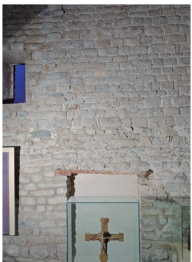
Zona central del mur la finestra ha estat oberta a mitjans del s. XX. La porta paredada amb arcaïtrau, no es correspon amb la porta exterior que es tanca amb un arc de mig punt. ©Mercè Marquès
