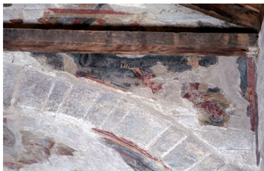
Detall de la figura després de la restauració, la biga ocultava part de la decoració. A la part superior de la sanefa, es veu una pota negra d'un animal que no té cabuda si tenim en compte el nivell i la inclinació actual del sostre. © Foto R. Ramos
