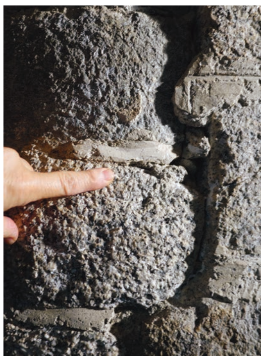
Detall amb llum rasant de la zona d'unió que permet veure la diferència entre els dos models de rejuntament. ©Mercè Marquès
