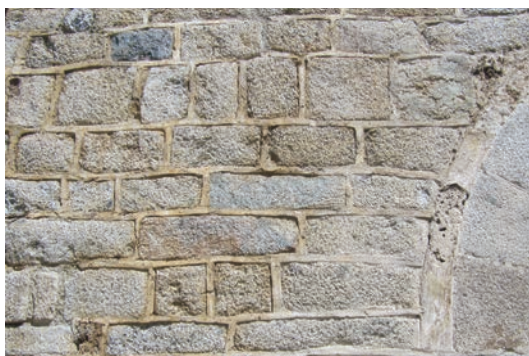
Façana de ponent. Zona a l'esquerra de la porta d'entrada. La decoració de junta de carreus es complementa amb el revestiment lliscat parcialment perdut, que es va aplicar sobre la franja de pedra de travertí de l'extradós de l'arc. ©Mercè Marquès
