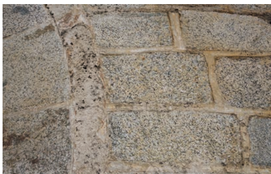
Detall de la ratlla blanca pintada sobre la decoració de junta. El morter aplicat en la junta, està curosament retallat per fer un rejuntament molt precís sense envair la pedra (façana oest). ©Mercè Marquès
