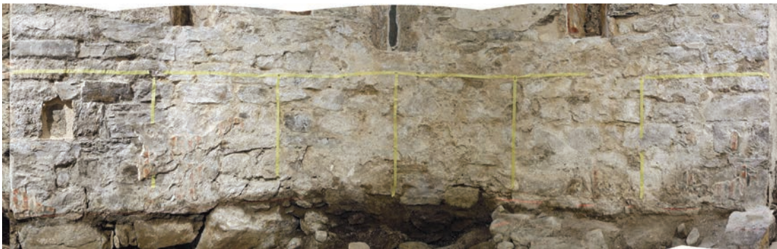
Muntatge panoràmic del primer nivell de l'absis després de la restauració. Zona corresponent a la primera fase de construcció de l'església. ©Muntatge fotogràfic de J. Giribet. Calidos
