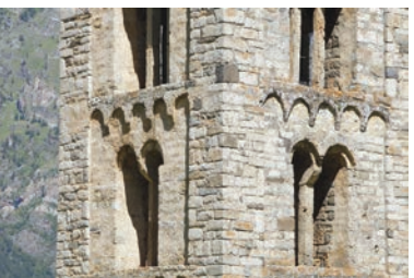
Nivell 2. Es conserva capes d'arrebossat que arriben fins a la cantonada i po- ques restes de policromia. © Foto J. Giribet. Calidos
