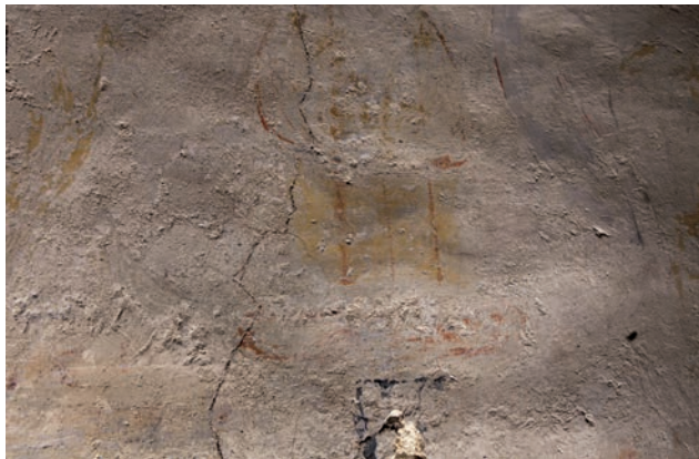
Línies de llinyola tirades per marcar la columna. © Foto R. Maroto CRBMC
