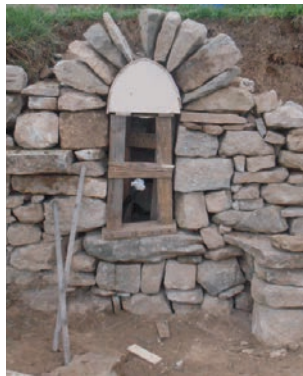
Disposició de les pedres sobre el cindri. Foto web.lafeixapedraseca.com
