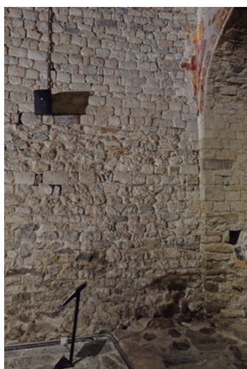
Mur nord cantonada amb l'absidiola. En aquesta zona, es combina material de la primera fase de construcció amb carreus ben tallats pertanyent a la segona fase constructiva. ©Mercè Marquès
