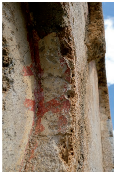
Arcuacions de les finestres amb policromia finestra © Mercè Marquès
