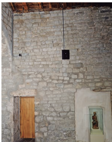
Cantonada del mur sud amb l'absidiola. Tot i que és una zona molt intervinguda, es pot veure com el material utilitzat per la construcció correspon a la primera fase de l'església. La porta dóna accés al campanar ©Mercè Marquès
