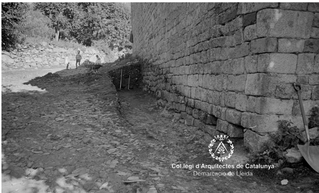
Rebaix del nivell del terra a l'exterior de la façana nord. Intervenció DGBBAA a 2a meitat del s. XX. Aquesta operació va posar al descobert la primera fase de construcció en aquest mur. Foto Arxiu Ferrant COAC Demarcació de Lleida
