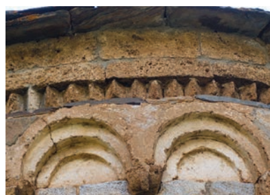
Protecció de la pedra amb recobriments de morter de calç i sorra. © Mercè Marquès
