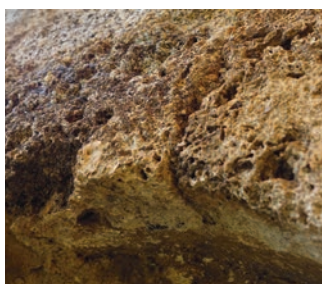
Detall de la biodegradació de la pedra. © Mercè Marquès
