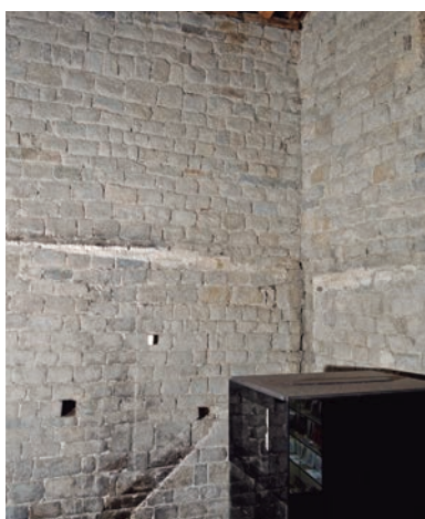
Cantonada del mur sud amb el mur de ponent. ©Mercè Marquès
