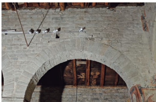
Primer arc former que arrenca del pilar de separació entre l'absis central i l'absidiola nord. Es conserva una zona de sanefa policromada que prové de la pintura de l'absidiola. ©Mercè Marquès
