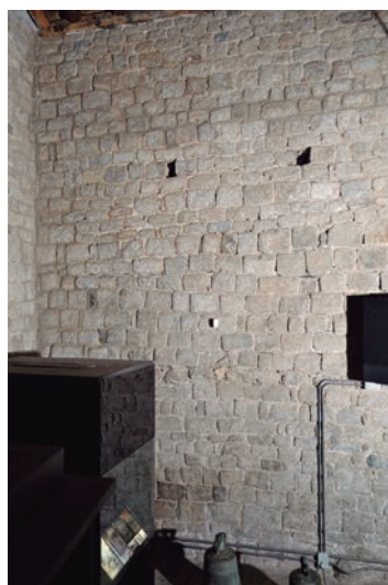
Zona del mur fent cantonada amb el mur de ponent. En aquesta zona la fàbrica del mur és regular, amb carreus de granit ben tallats. ©Mercè Marquès
