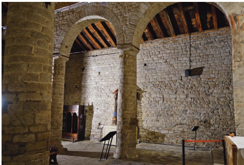
Vista general del mur de la façana nord des de la nau central. ©Mercè Marquès
