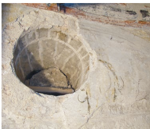
La segona decoració de junta de carreus en la zona de l'òcul, es realitza aplicant un revestiment a la pedra i posteriorment, s'hi pinta la ratlla blanca simulant uns petits carreus. ©Mercè Marquès
