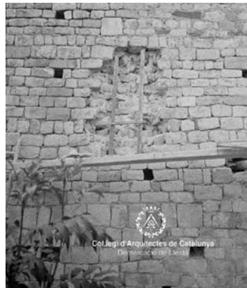
Obres de restauració del mur de la façana oest. Intervenció A. Ferrant. Foto Arxiu Ferrant. COAC Demarcació de Lleida
