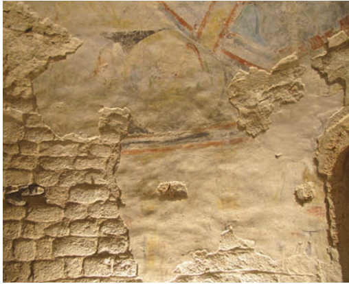
Fotografia amb llum rasant de la zona que mostra les irregularitats de l'arrebossat, que s'adapta a la morfologia del mur. © Mercè Marquès
