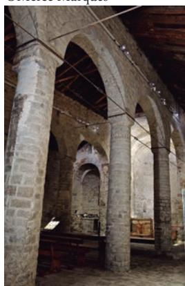
Vista general de les columnes entre les naus d'ornament, no tanquen tot el perímetre de la columna sinó que són visibles únicament des de la nau central. La visió des de la nau nord està desproveïda d'ornament. ©Mercè Marquès
