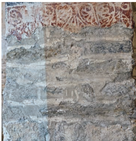
Primera decoració de junta de carreus. Pilar de separació entre la nau central i la nau sud. ©Mercè Marquès
