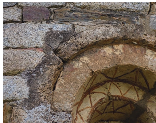
Detall de la finestra de l'absis. Per sota del primer arc, hi ha unes franges gruixudes de color vermellós que s'alternen amb el color blanc de la calç. Sobre els carreus del mur hi ha unes restes de color vermell coincidint amb la zona de la junta. ©Mercè Marquès
