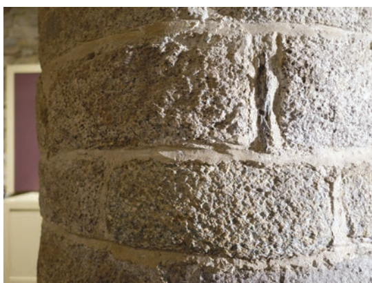
Segona decoració de junta de carreus. Detall amb llum rasant. Es pot veure el repretat del morter amb el paletí, fet amb la finalitat que el morter s'endinsi cap a l'interior de la junta. ©Mercè Marquès
