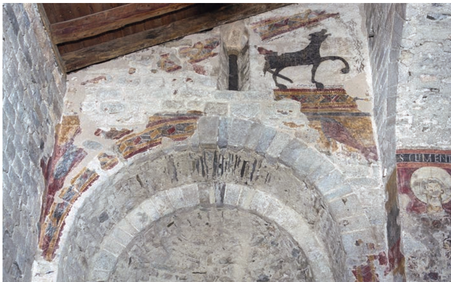
Mur de tancament de la nau nord i frontis de l'arc de l'absidiola nord. © Foto R. Ramos
