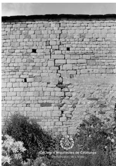
Esquerda estructural en la façana sud. Foto Arxiu Ferrant COAC Demarcació de Lleida
