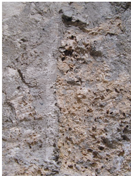
Detall de la ratlla blanca pintada sobre el morter gris. ©Mercè Marquès
