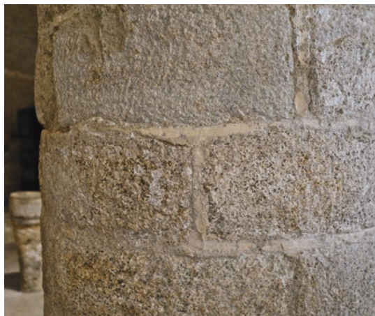
Segona decoració de junta de carreus. Detall de l'aplicació de la pinzellada blanca. ©Mercè Marquès
