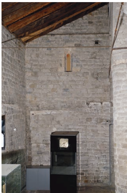
Mur oest. Part corresponent a la nau sud. Es conserven les empremtes del trespol del cor desaparegut. ©Mercè Marquès
