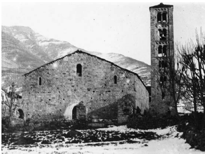
“Vista general de Sant Climent de Tahull” de Josep Danès i Torras. Circa 1922. AFCEC. En la fotografia, es veuen uns pilars que podrien ser els que sostinguessin l'estructura del porxo. A la banda dreta de la fotografia, es veu que el mur d'unió actual entre l'església i el campanar era diferent.
