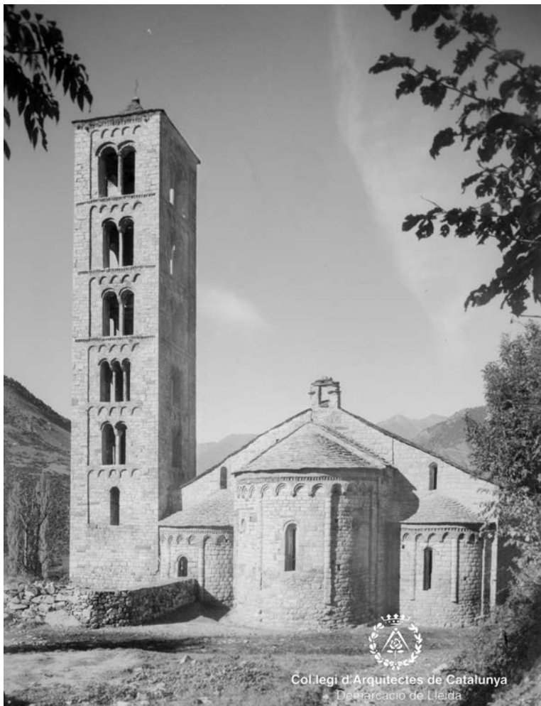
Època final de les obres de restauració d'Alejandro Ferrant, arquitecte restaurador de la DGBBAA anys 70's del segle passat. El nivell del terra exterior de l'església, s'ha regularitzat, totes les finestres tant de l'església com del campanar estan obertes i les teulades dels absis estan reconstruïdes. Foto Arxiu Ferrant COAC Demarcació de Lleida
