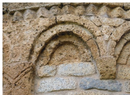
Utilització del travertí per la realització dels elements escultòrics © Mercè Marquès
