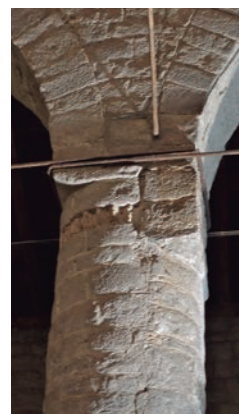
Vista de la columna 6 des de la nau central. ©Mercè Marquès
