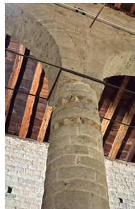
Columna 2 vista des de la nau central. Ornament escultòric amb dos frisos de dent de serra . ©Mercè Marquès
