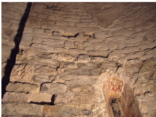
Costat esquerre de l'absis. Il·luminació amb llum rasant; s'aprecia el límit entre la primera i la segona etapa constructiva. ©Mercè Marquès
