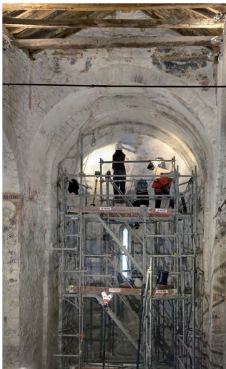
Treballs de restauració. Podem comprovar l'escala del personatge representat en aquesta imatge d'ambient de treball. © Foto J. Gilibert Calidos
