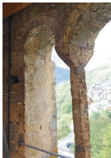
Intradós estret dels nivells superiors de la torre. L'arrebossat cobreix tota la superfície. ©Mercè Marquès
