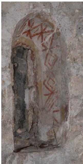
Finestra situada a la part inferior esquerra amb la 2a decoració pictòrica. © Mercè Marquès
