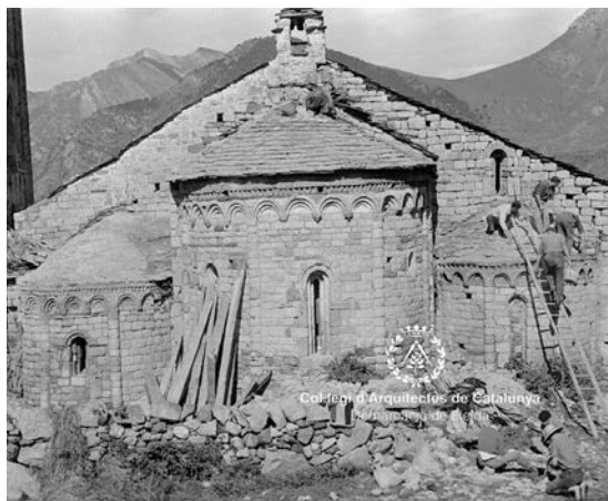
Reparació del mur de tancament de les naus. Reconstrucció de la zona del mur amb les esquerdes estructurals, ja s'ha eliminat el paredat del costat dret, però no el de la finestra esquerra. La finestra de l'absidiola nord, encara està paredada. En aquests moments, s'estan desmuntant les teulades per la seva reconstrucció. Foto Arxiu Ferrant COAC Demarcació de Lleida
