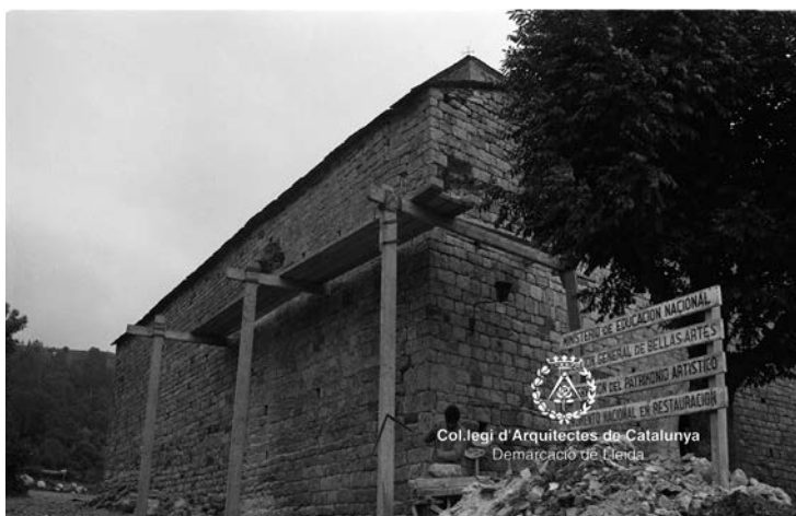
Treballs de restauració del mur nord. Les bastides emprades de taulons de fusta lligats amb cordes, utilitzen els orificis del mur romànic per ancorar-se. Foto Arxiu Ferrant COAC Demarcació de Lleida
