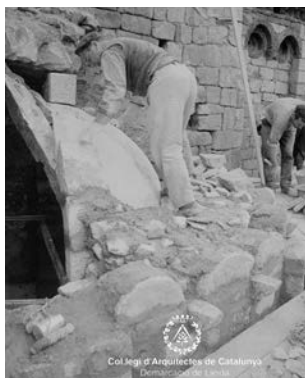
Reconstrucció de l'absis de Sta. M a de Taüll. Col·locació de la primera pedra de l'arc. Foto Arxiu Ferrant COAC Demarcació de Lleida
