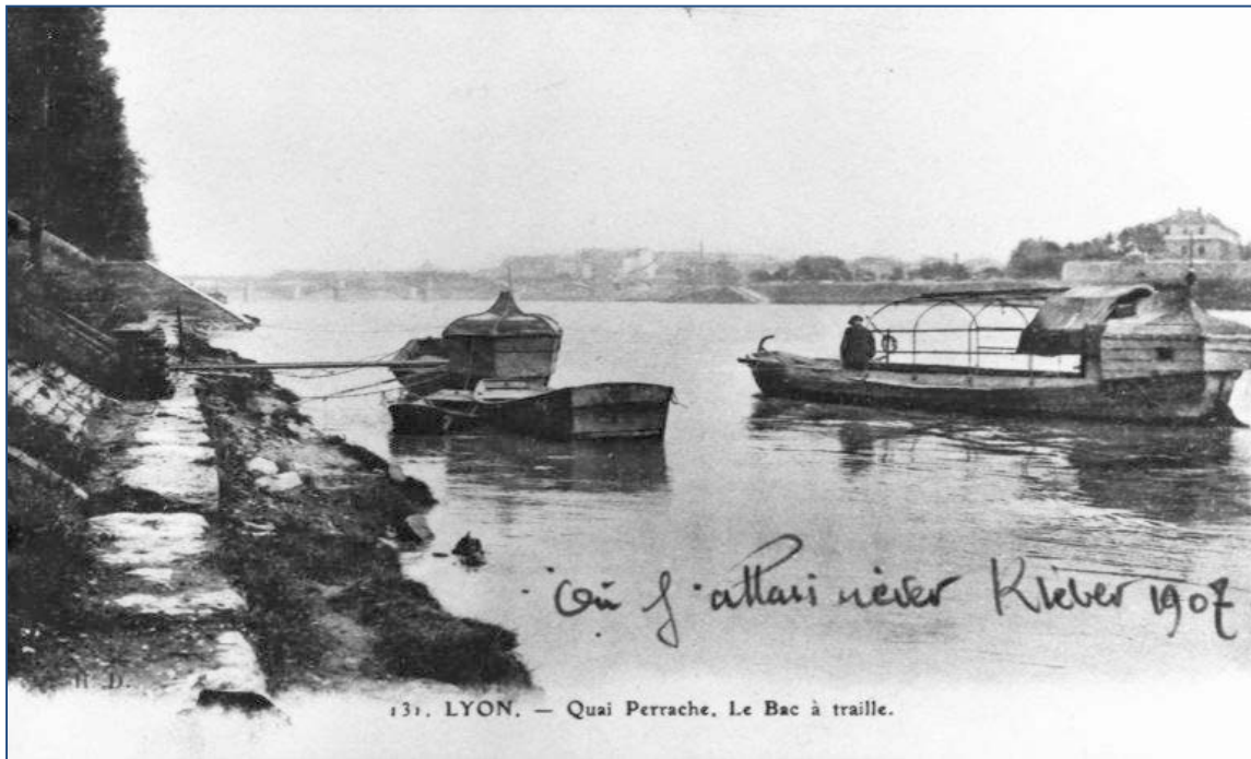
Figura 8.10: Fotografia feta al quai Perrache de Lió el primer quart del segle XX que representa el sistema del bac à traîle , caracteritzat per un cable de suspensió que permet als vaixells creuar el Roine.
