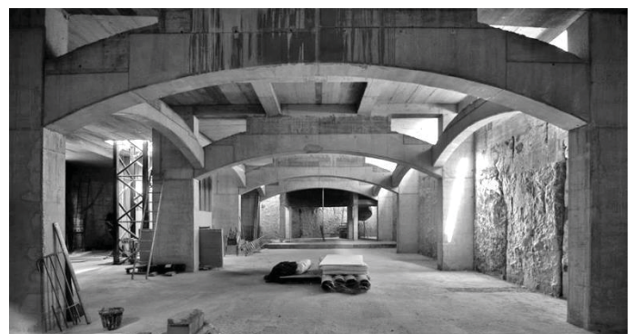
Figura 3. Estado actual de las obras del sótano de la Iglesia Ortodoxa Rumana de Barcelona. [ http://www.bisericabarcelona.es/ ]
