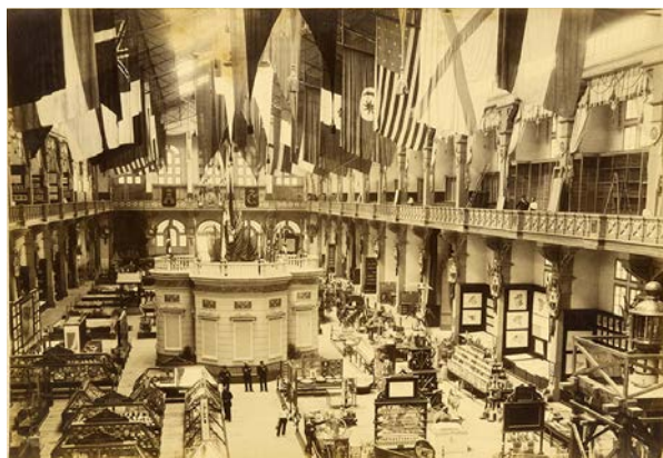
Audouard i Cia. Interior de la nave central del Palacio de la Industria, Exposició Universal de Barcelona, 1888 © AFB
