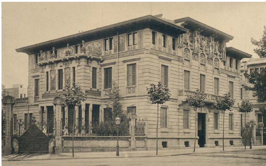
Palacio propiedad de D. Ramon Montaner. Lámina XL en Arquitectura moderna de Barcelona . Francesc Rogent ( et alt. ) Barcelona: Parera y Cia. editores, 1897 © LBP
