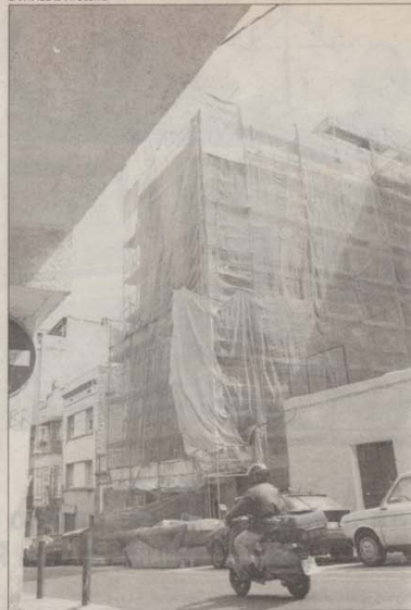
Fincas 57 de la calle de Montseny, que está siendo rehabilitada.
