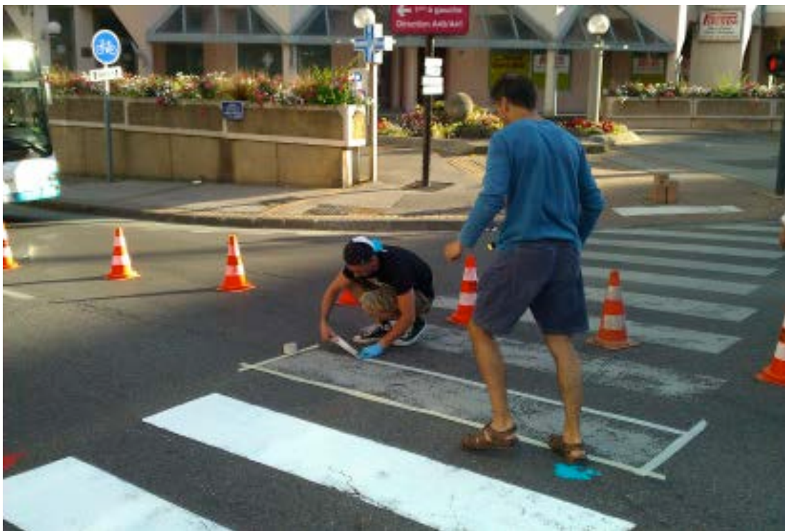
FIGURE 44. PHOTOS DE L'INTERVENTION DE RÉFECTION DES PASSAGES PIÉTONS
