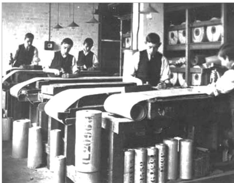
Fig. 3-6: Fase de picat manual de les matrius en una empresa londinenca l'any 1911, abans d'introduir-les a la màquina per fer les còpies en sèrie a mida comercial. Font: Pianola Institute.
