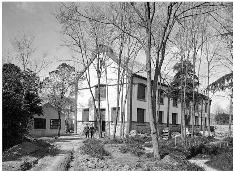
Fig. 3-3: Una de les poques imatges que es conserven de l'exterior de la fàbrica de rotlles construïda per Manuel Raspall. Font: Fons Manuel Blancafort, BC.
