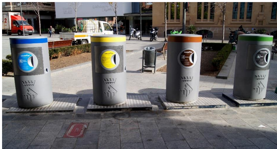
Fig. 2.14 - Buzones del sistema de recogida neumática de Barcelona.
