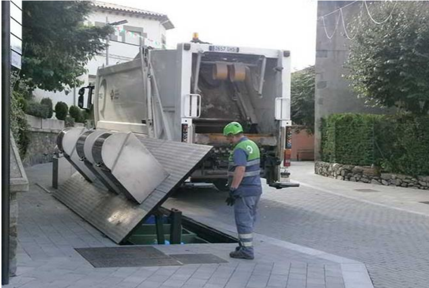
Fig. 2.13 -.Recogida mediante contenedores soterrados en Sant Pere Torello.
