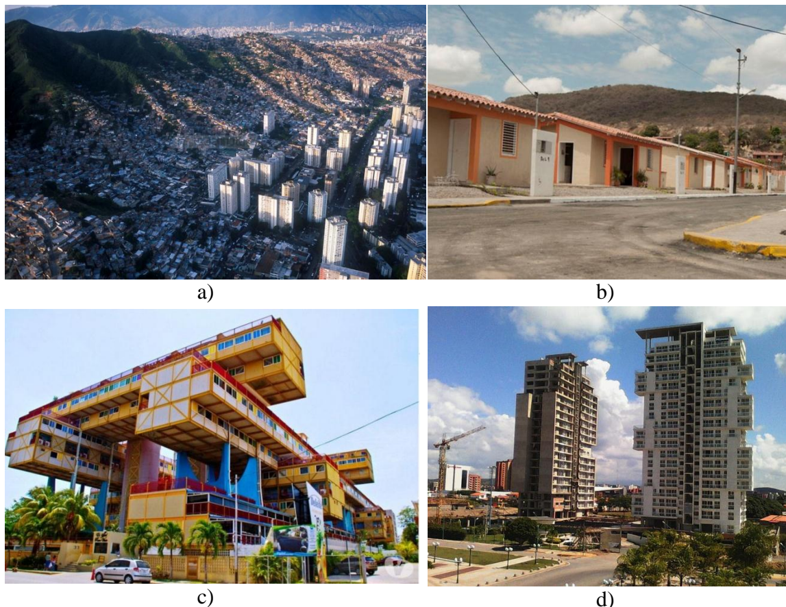
Figura 3.1 a) Edificios y urbanismo en Caracas, b) Vivienda típicas en diferentes ciudades, c) Edificio de vivienda multifamiliar Lecherias, d) Edificios modernos en construcción Barquisimeto
