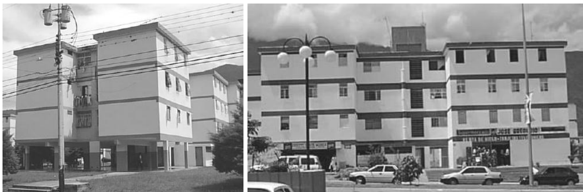
Figura 3.3 Edificios en Mérida-Venezuela con: a) con planta baja libre y b) con discontinuidad en planta
