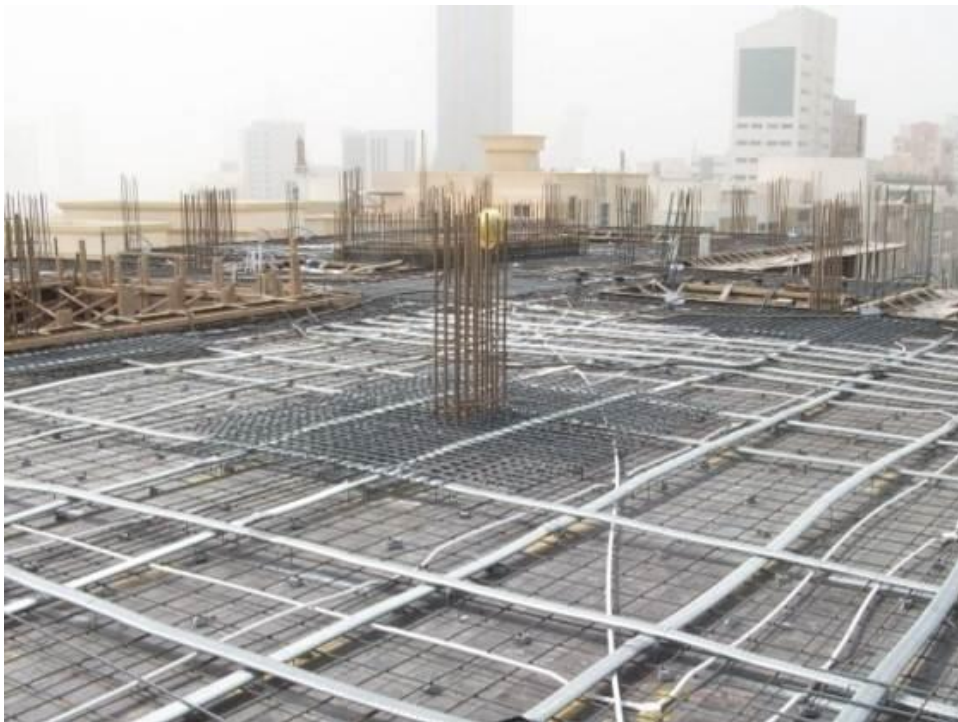
Fotografía 1-3. Detalle de la concentración de armadura junto a un pilar en un momento de la ejecución de una losa postesada (poco antes de su hormigonado)
