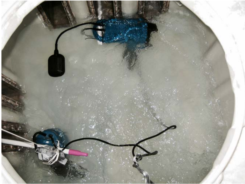
Figura A60. A l'interior dels tancs hi ha bombes submergibles que actuen d'agitadors. Així, la suspensió és completa.
