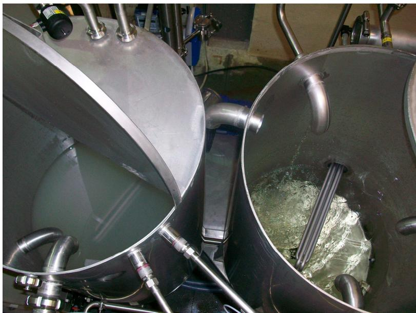
Figura 4.37. Tanque de la planta piloto donde se recoge el agua antes y después de la microfiltración.
