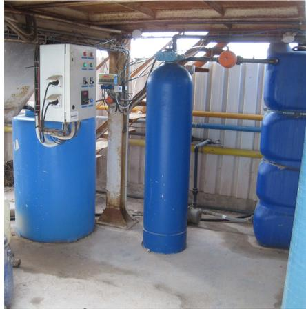
Figura 1.9. Equipo de intercambio iónico.
