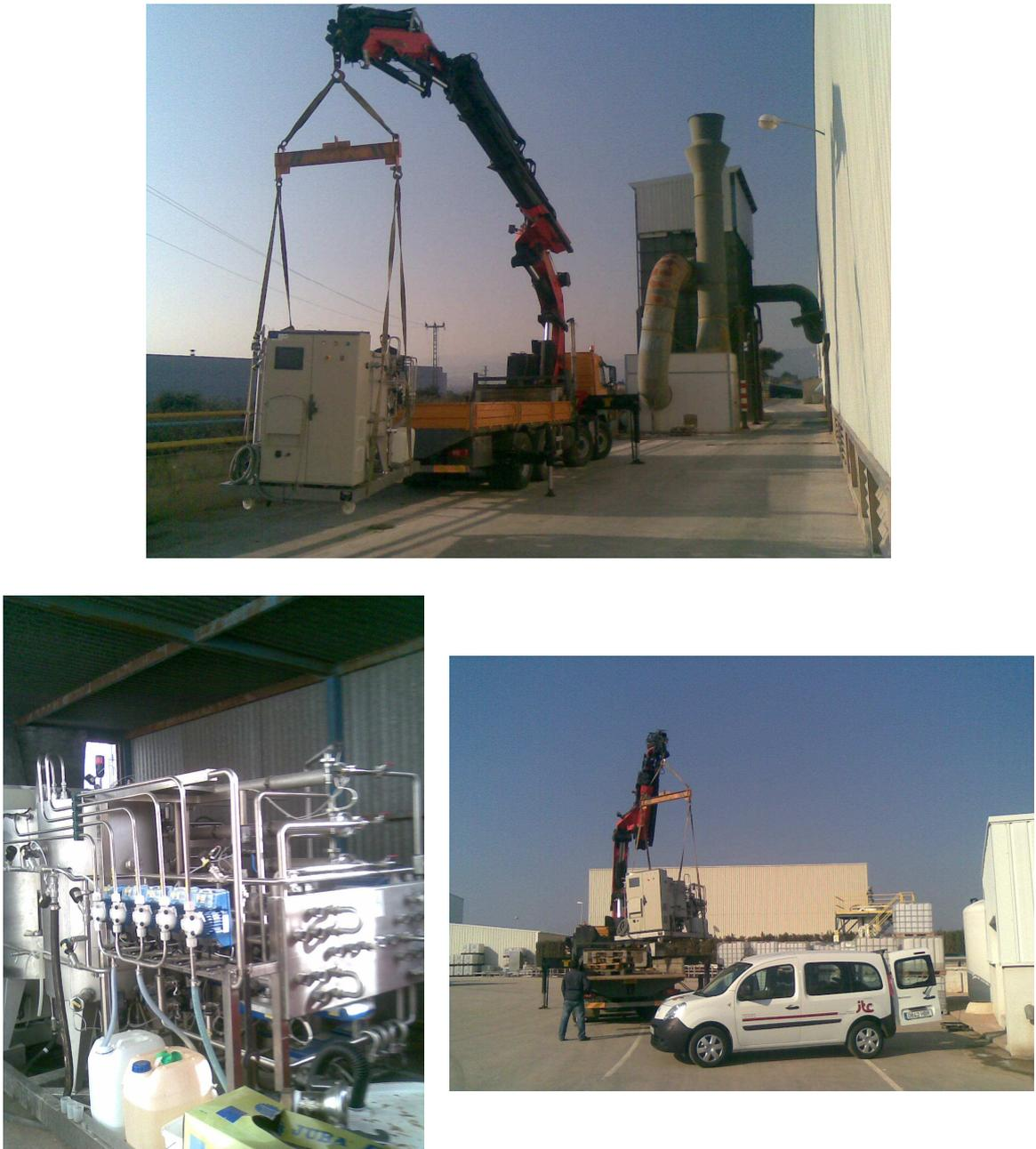
Figura 4.28. Imágenes del traslado y ubicación de la planta piloto hasta la empresa de fabricación de baldosas cerámicas.
