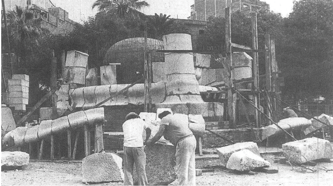
fig. 188 Obres de reconstrucció. Agost de 1981.
