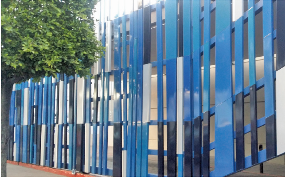
Fig. 24. Fachada cubierta con los elementos de la lamina porcelanizada. Foto: Sylwia Ulicka
